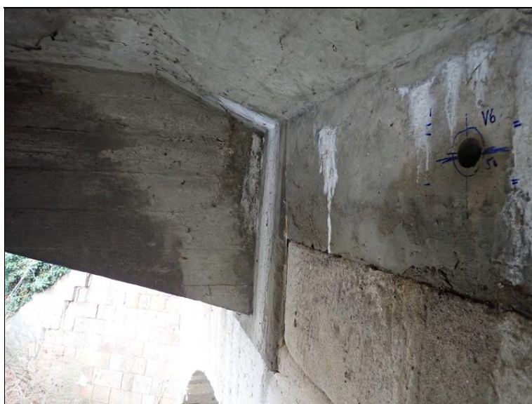
Silné výluhy a stopy zatékání čelní zdi.
