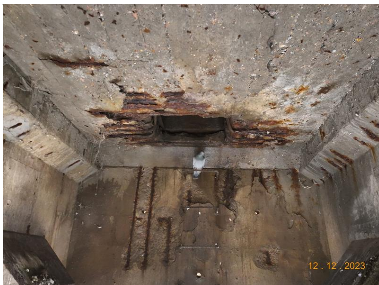
063_Pole č. 5 podhled NK mezi N4 a N5. Degradace betonu a koroze výztuže.jpg
