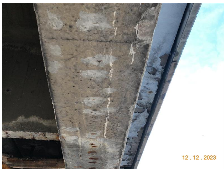
040_Pole č.3 podhled NK, N6. Výskyt podélných trhlin s výluhy v dolní pásnici nosníku.jpg
