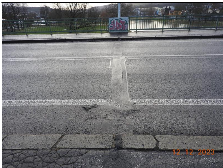
105_MZ P3. Příčná trhlina.jpg
