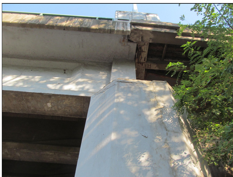
Detail degradace omítky na levém boku opěry OP1, separace povrchových vrstev.
