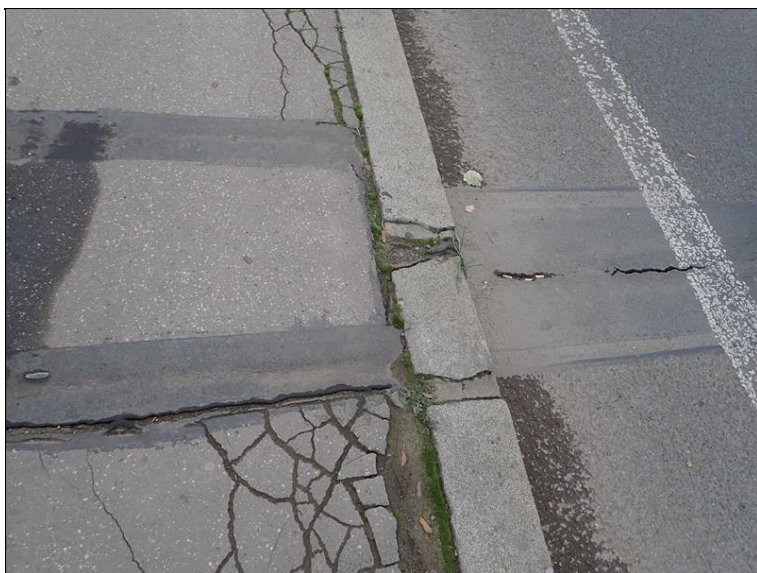
Dilatační závěr nad piliřem 5. Je odtržený, v okolí trhliny, zejména v chodníku.
