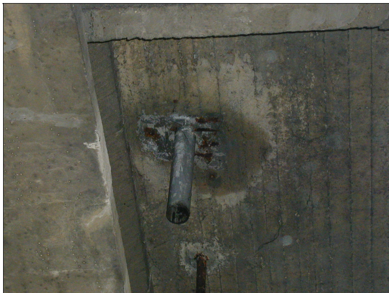
Obnažená korodující výztuž v okolí trubky odvodnění izolace na sp. líci desky mostovky.
