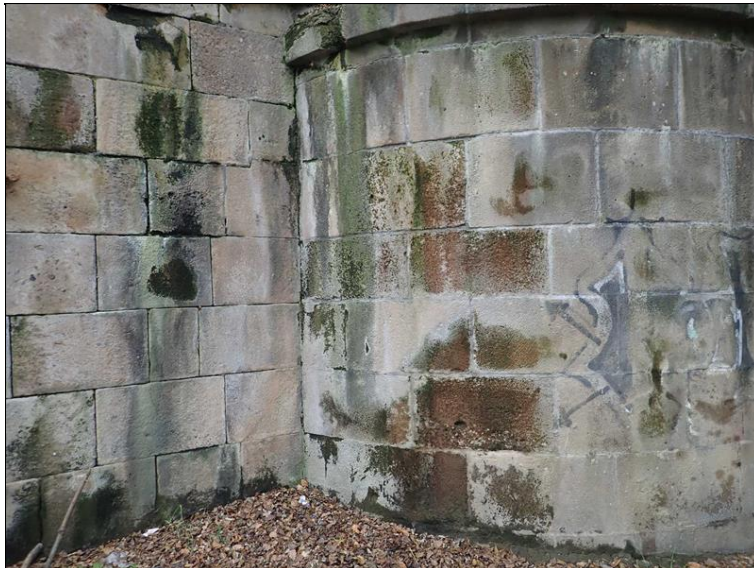
Levé křídlo a dřik opěry 7 - mokré zdivo, stopy zatékání.
