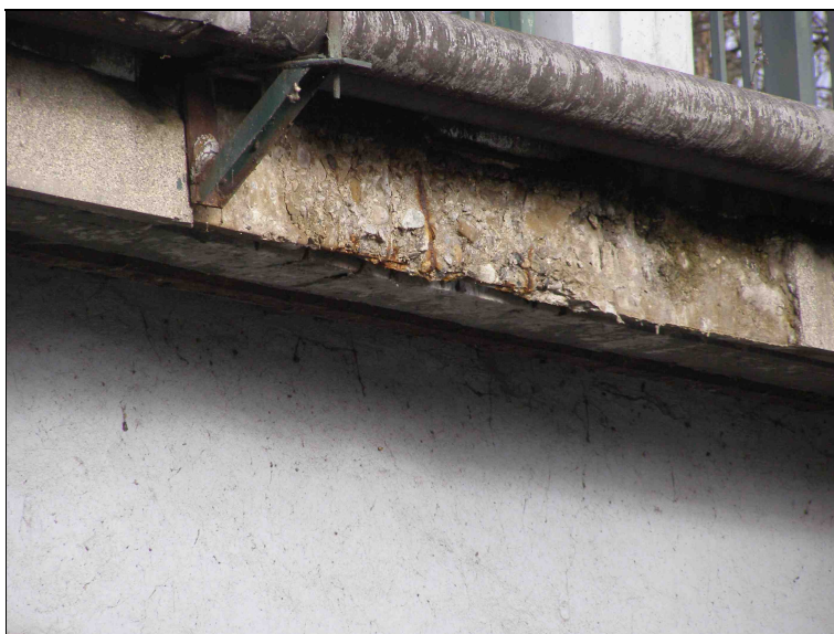
Degradace betonu klenby.
