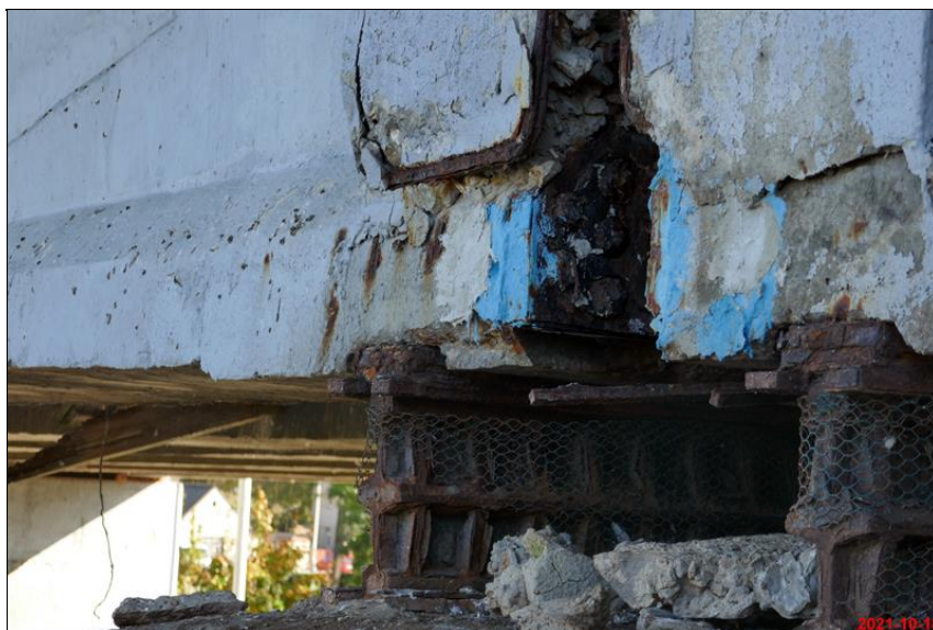
239_5_koroze kotevni oblasti NK.JPG
