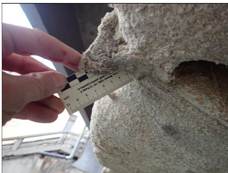
Levá hrana klenby - dodané spárování má vyšší odolnost než pískovcové kvádry, je vidět, že od rekonstrukce zdegradovaly cca 1-2 cm.
