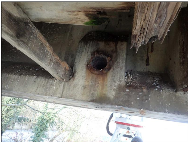
Pole 4: lávka ke stálému zařízení je velmi shnilá a hrozí zřícení.
