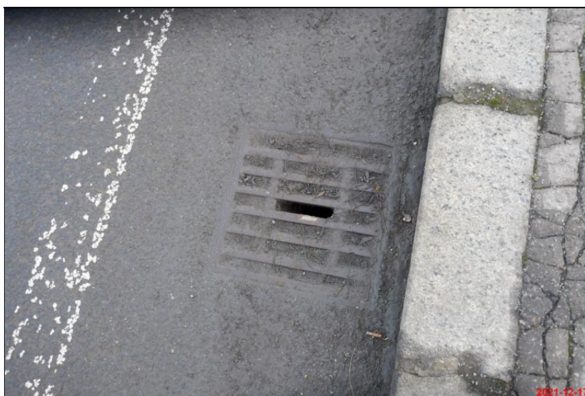
421_zaneseny odvodnovac.JPG
