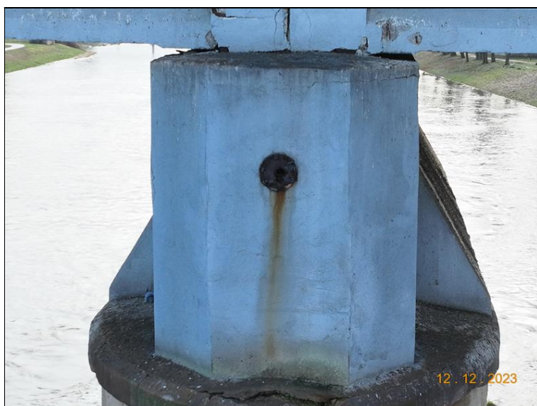
056_P5 zprava. Degradace betonu v horní části pilíře.jpg
