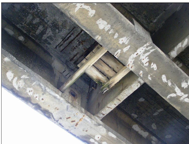
Podhled mostovky - lávky přístupu ke stálému zařízení - koroze výztuže desky mostovky
