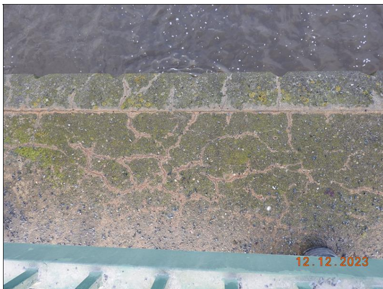
096_Pravá řimsa - typická porucha - síť trhlin.jpg
