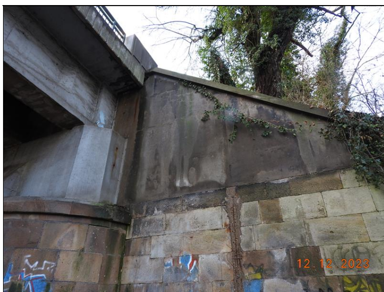
083_Pravé křídlo OP7. Stopy po zatékání, všesměrné trhliny.jpg
