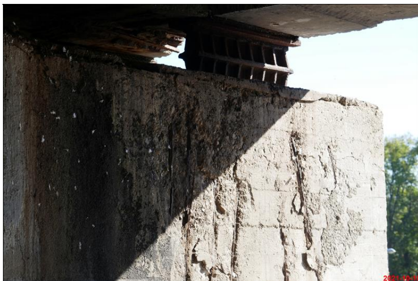
133_degradace betonu pilire.JPG
