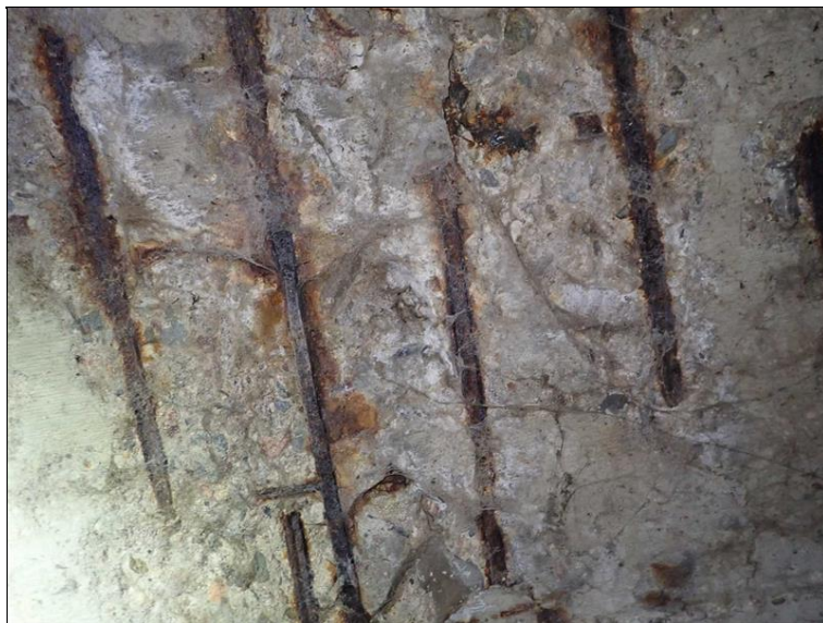
Deska mezi trámem a čelní zdí - koroze výztuže s oslabením až cca 30 %.
