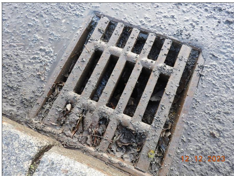
115_Odvodňovač. Mírně zanesený, poškozený.jpg
