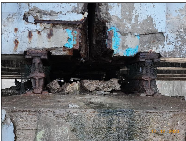
047_P4 ložiska zprava. Rozsáhlá koroze ložisek a kotevní oblasti.jpg
