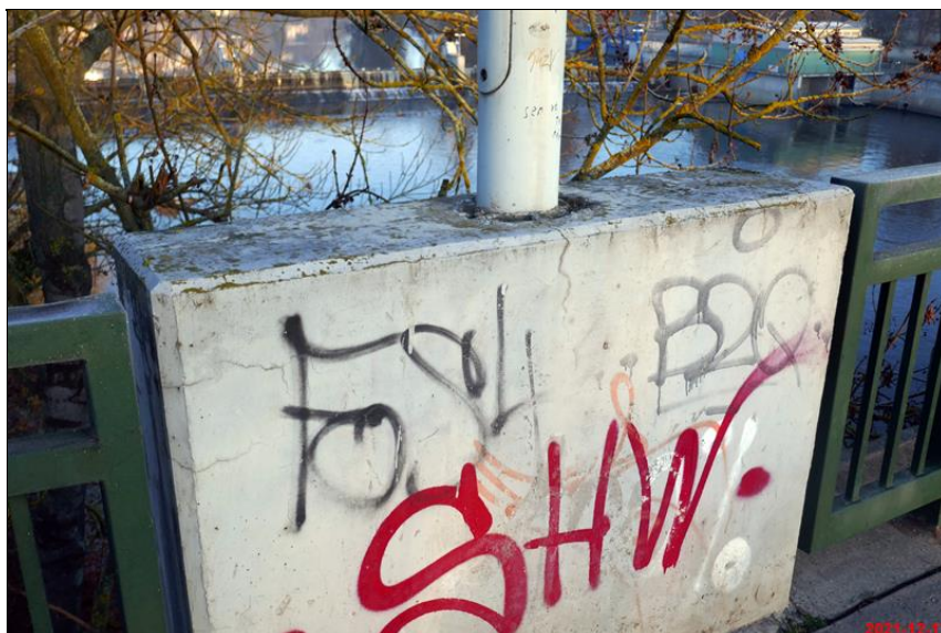
443_sit trhlín v betonovém zábradlí.JPG
