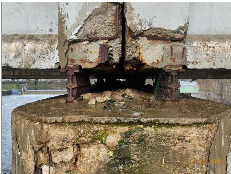
045_P4 ložiska zleva. Rozsáhlá koroze, stopy po zatékání.jpg
