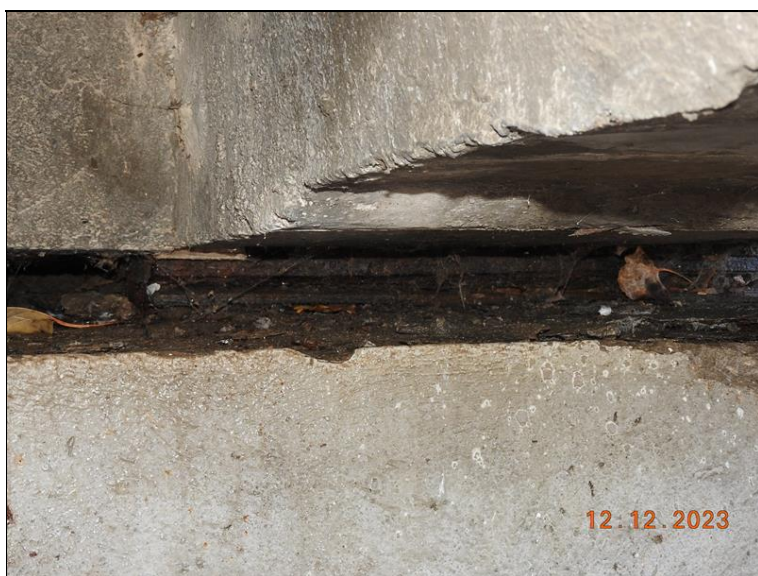
086_OP7 ložisko č. 6. Rozsáhlá koroze, stopy po zatékání.jpg
