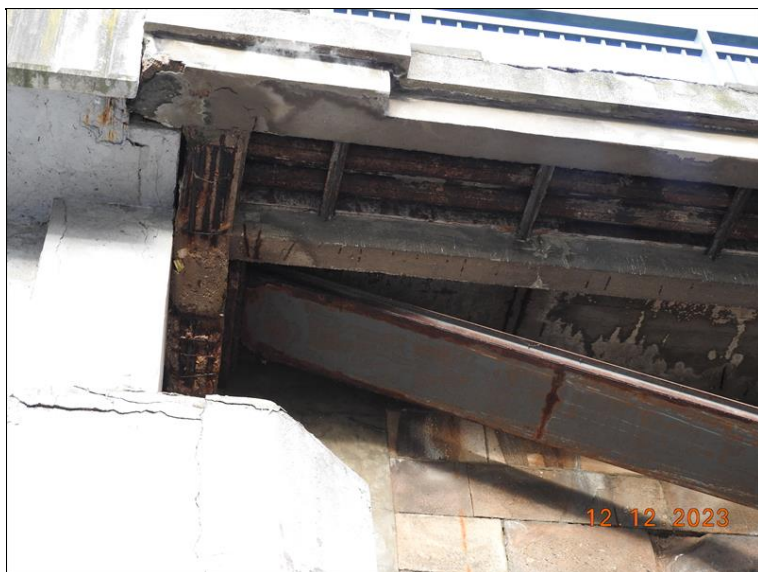
009_Konzola ZZ u OP1 zleva. Rozsáhlá korozí výztuže a stopy po zatekání.jpg
