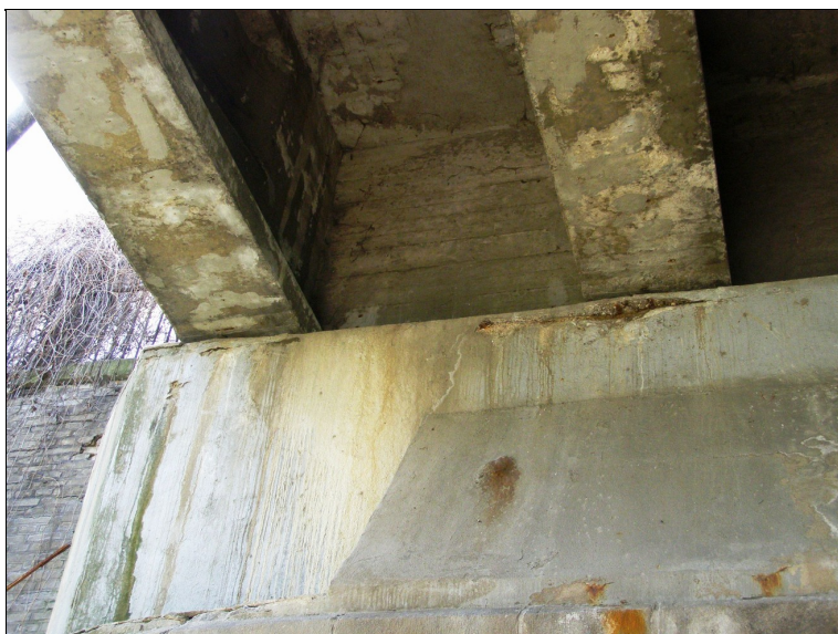
Levá strana OP7 - zatékání na úložný práh - separace krycí vrstvy, koroze výztuže
