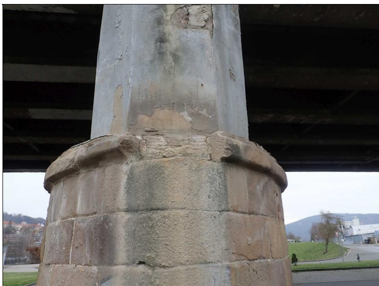
Rozpad kamenného límce Pil 4.
