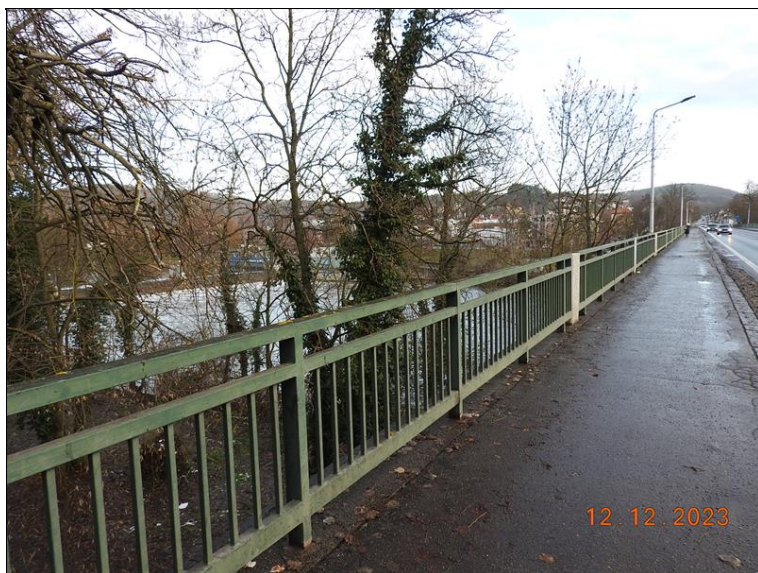
091_Zábradlí, vpravo. Poškození PKO, koroze v místě kotvení.jpg
