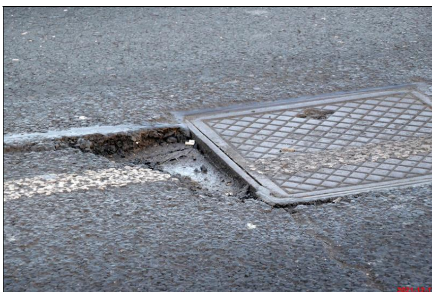
430_vytluk v miste revizního vstupu_drži se v nem voda.JPG
