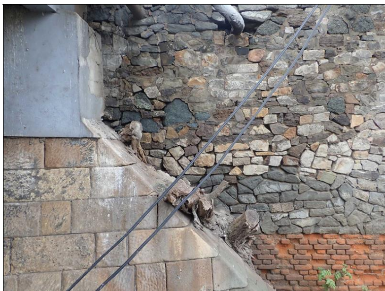
Stav zdiva klenby - vrchol, levý bok. Degradace se projevuje nejvíce na hranách klenby - odpadlo až cca 5 cm.
