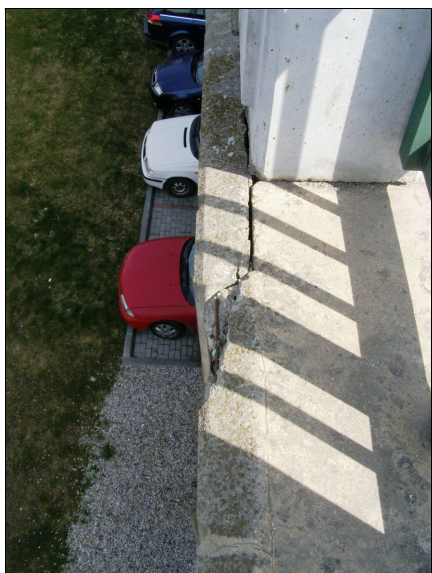
Římka - lokální rozpad betonu, koroze výztuže
