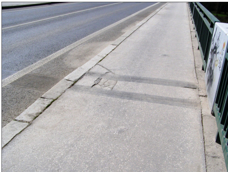
Římka - lokální rozpad betonu, koroze výztuže
