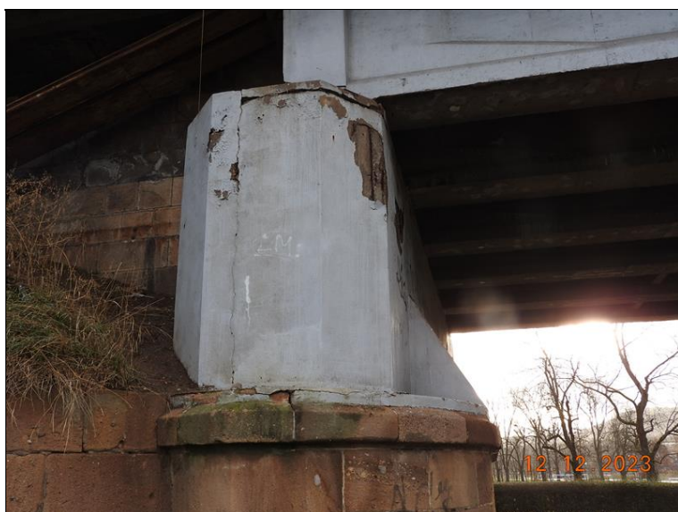
007_OP1, zprava - detail. Svislá trhлина v celé výšce bet. konstrukce, separace krycí vrstvy a koroze výztuže.jpg
