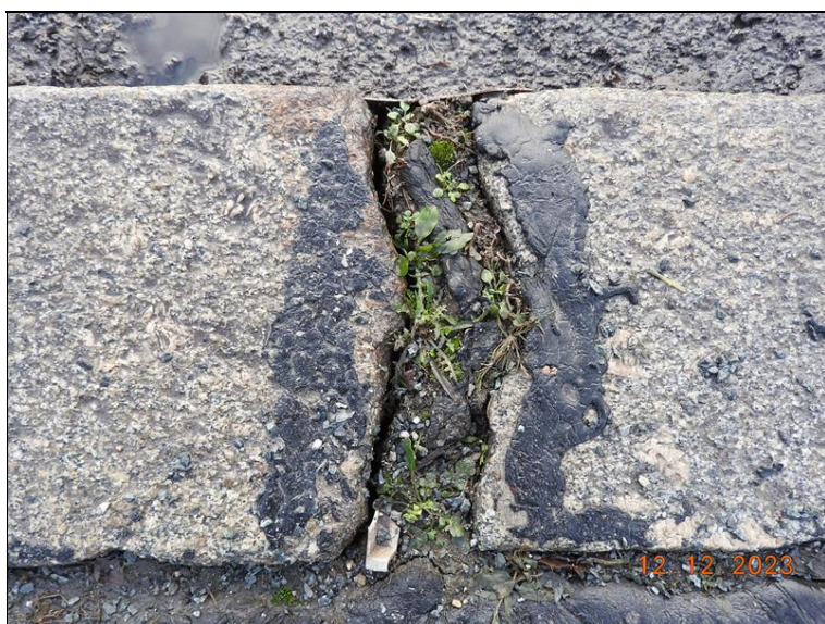
107_MZ P4 - detail. Degradace těsnící zálivky.jpg
