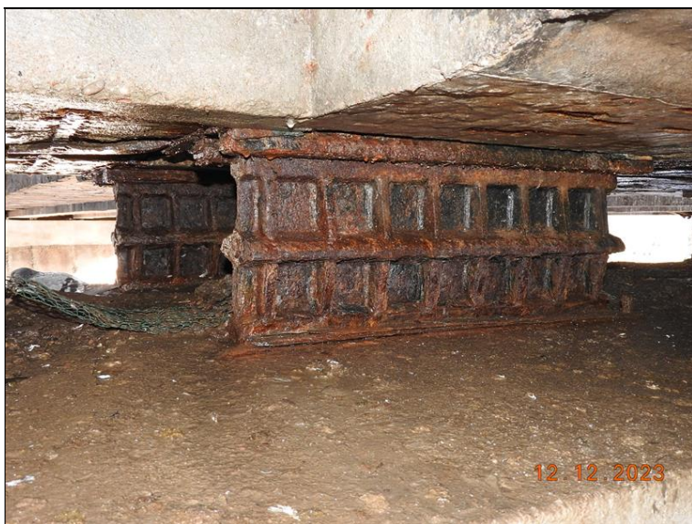
074_P6 ložisko 5. Rozsáhlá koroze, chybějící ochranná síť.jpg
