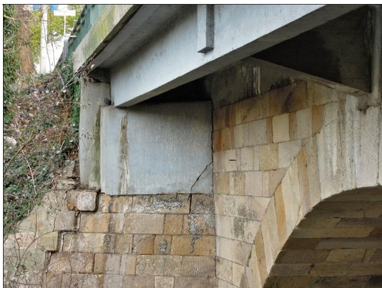
lokální porucha úložné stěny rozšíření - OP1, PS
