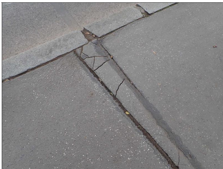
Nezatěsněná dilatační spára.
