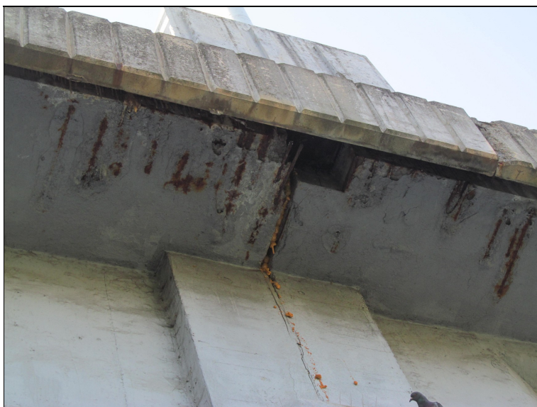
Prokreslená korodující výztuž na spodním líci pravé konzoly.
