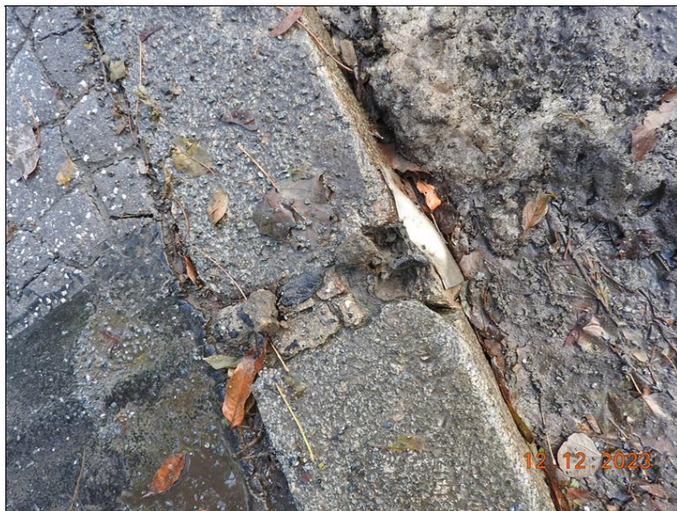
114_MZ OP7 - detail. Porucha v místě obrubníku.jpg
