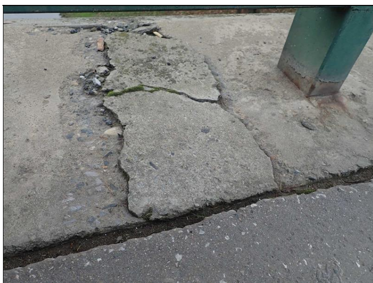
V betonu římsy jsou příčné trhliny, v jednom místě odpadá kus betonu. Počínající koroze zábradlí v patě.
