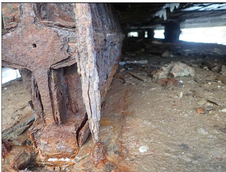
Ložisko nad Pil 5: úplné zkorodování kotevního prvku ložiska.
