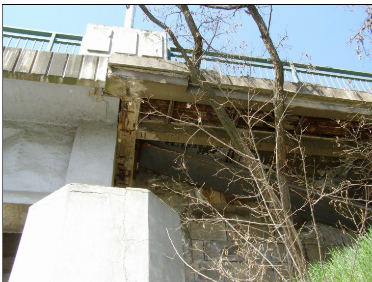
Levá strana OP1 - koroze výztuže žb chodníkové konzoly
