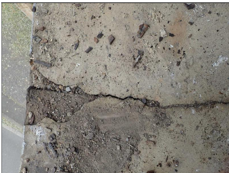
Trhlina v úložném prahu opěry 1 vpravo.
