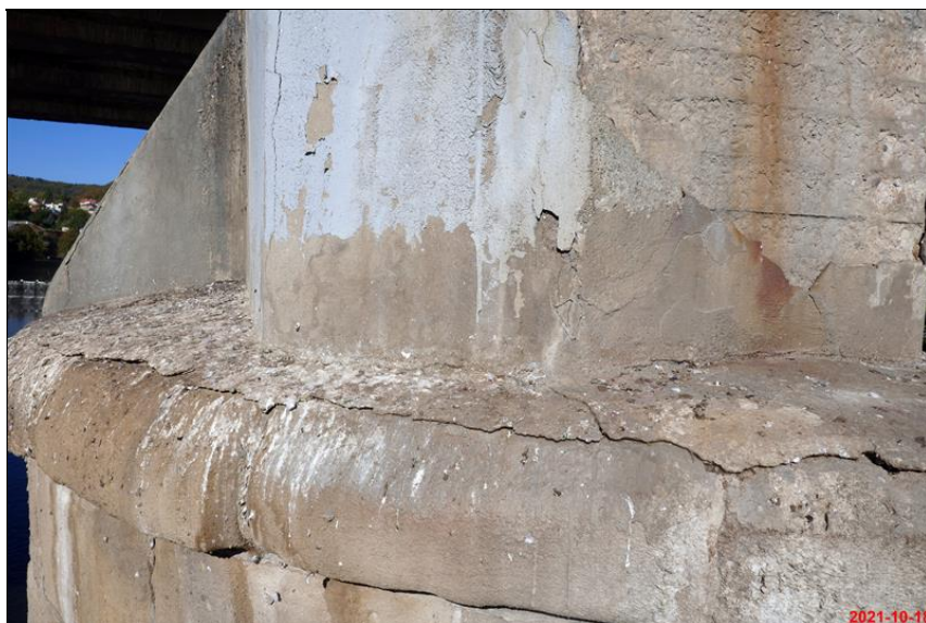
134_trhliny v betonu pilire.JPG
