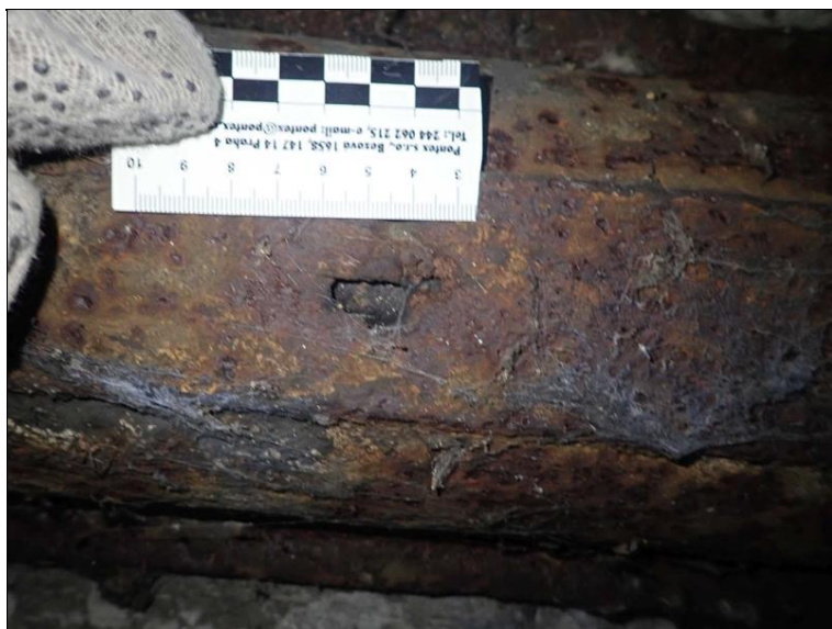
Plechý sloužící pravděpodobně za uchycení inženýrských sítí korodují, lokálně skrz.
