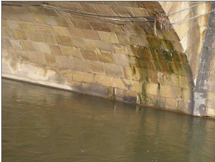
Silný průsak klenbovým pasem v patě klenby.
