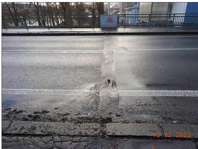
112_MZ OP7. Zvlnění vozovky, neodtékající voda.jpg
