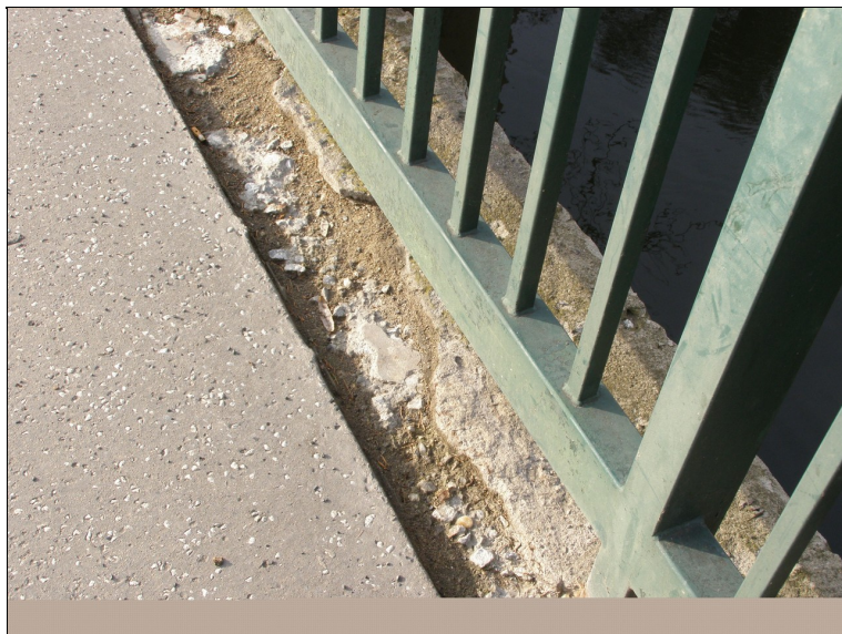
Degradace betonu na pravé římse.
