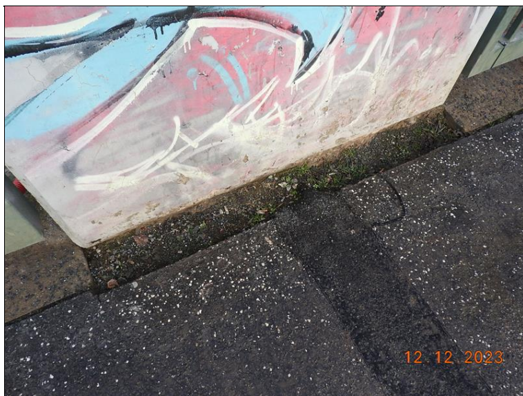
100_Pravý chodník nad P3. Chybí těsnící zálivka.jpg
