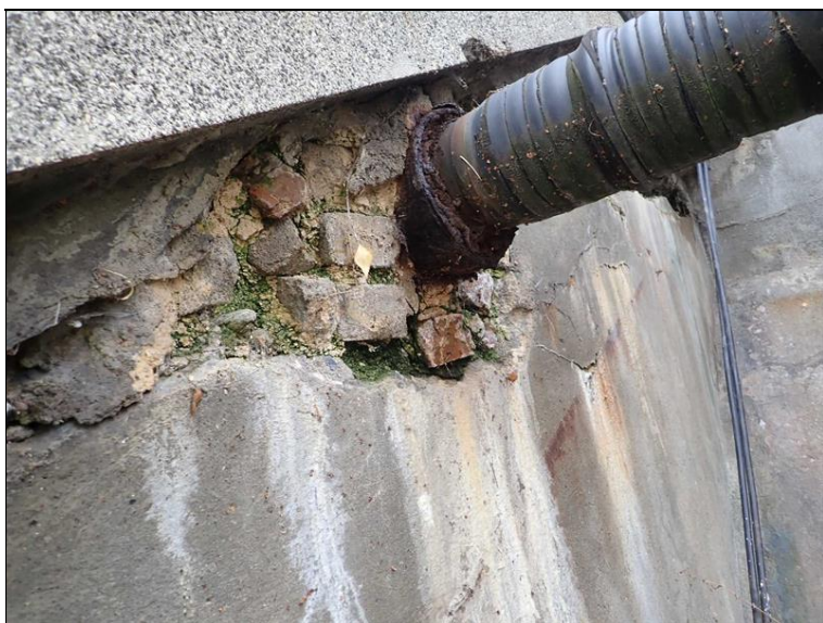
Navazují zeď u opěry 2 vlevo - silné výluhy, degradace zdiva.
