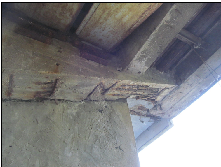
Spodní líc koncového příčniku na opěrou OP1 na pravé straně, odhalená betonářská výztuž silně koroduje.
