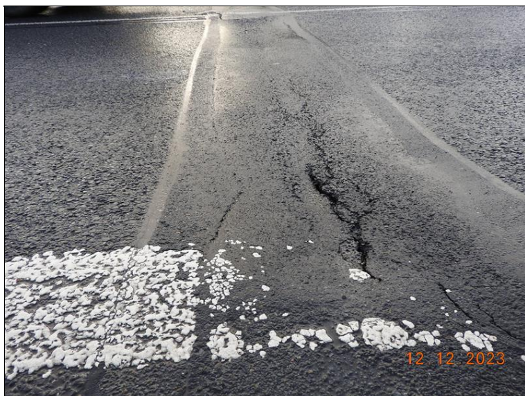
111_MZ P6 - detail. Příčná trhlina v celé šíři, všesměrné trhliny.jpg
