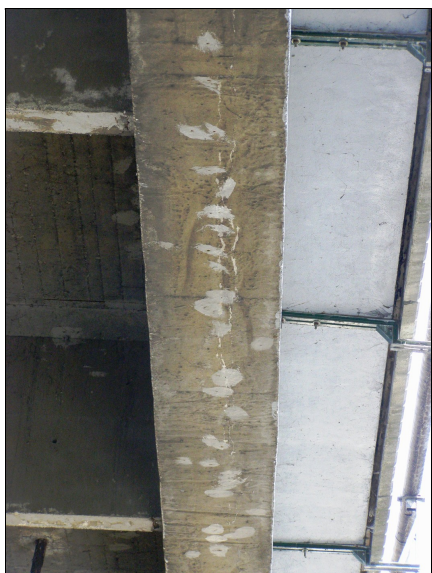
Spodní líc trámu NK - podélné trhliny s výluhy pojiva
