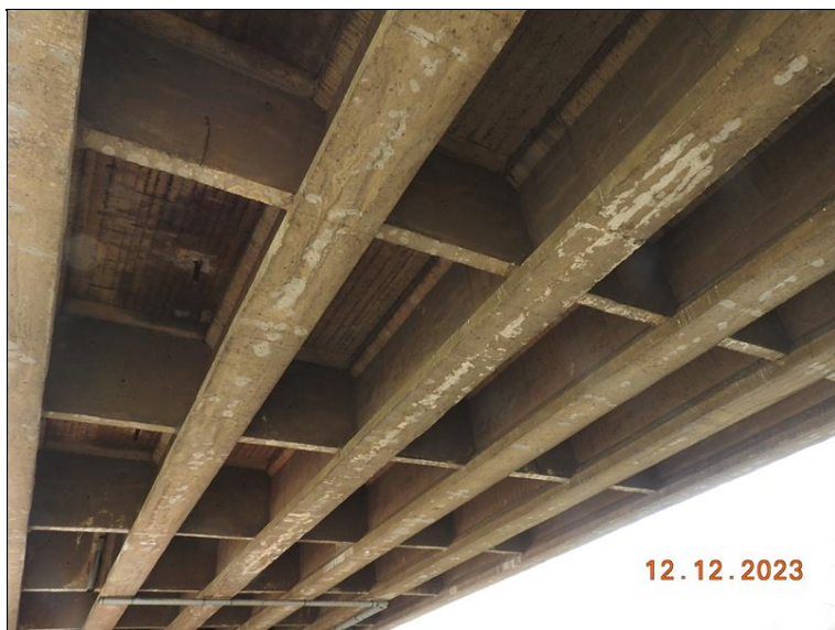
012_Pole č. 1, podhled nosné konstrukce. Degradace betonu, stopy po zatékání a koroze výztuže.jpg
