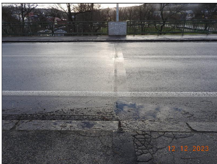
101_MZ OP1. Příčná trhlina v celé šíři, všesměrné trhliny.jpg
