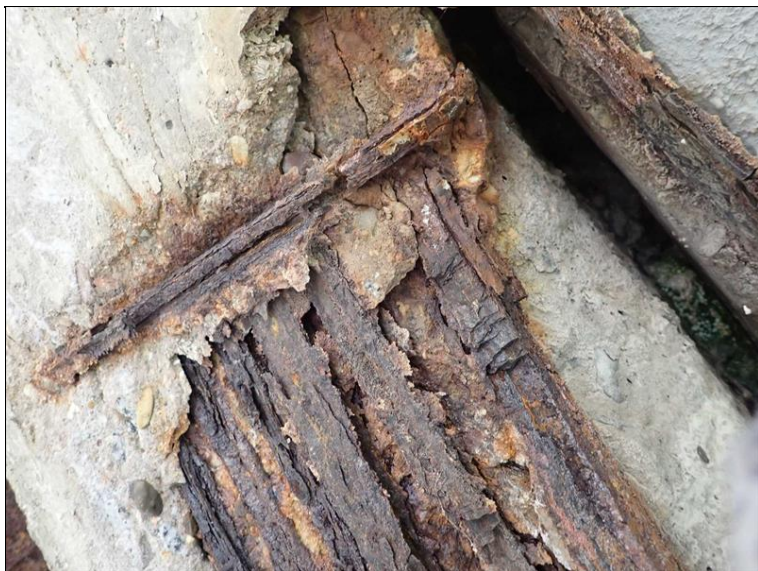
Vrstevnatá koroze výztuže konzoly.
