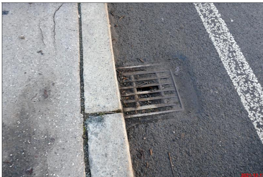
441_zaneseny odvodnovac.JPG
