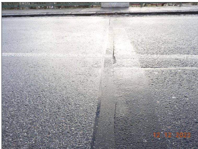
102_MZ OP1 - detail. Příčné trhliny.jpg
