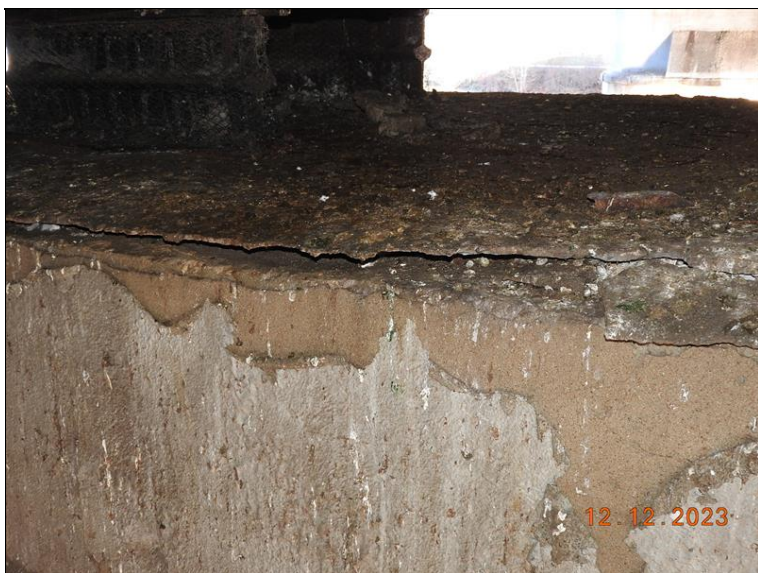
073_P6. Separace krycí vrstvy úložného prahu, zanesení trusem.jpg
