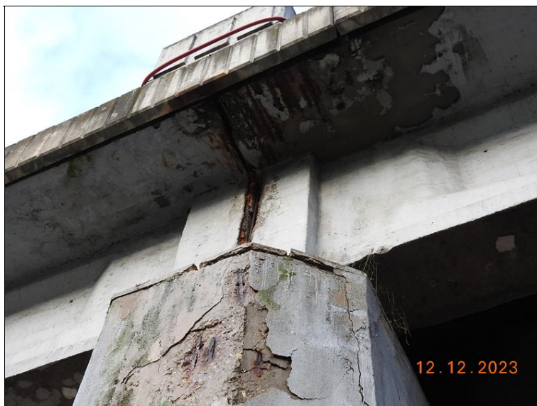
018_Dilatace nad P2. Stopy po zatékání, koroze výztuže a separace krycí vrstvy.jpg
