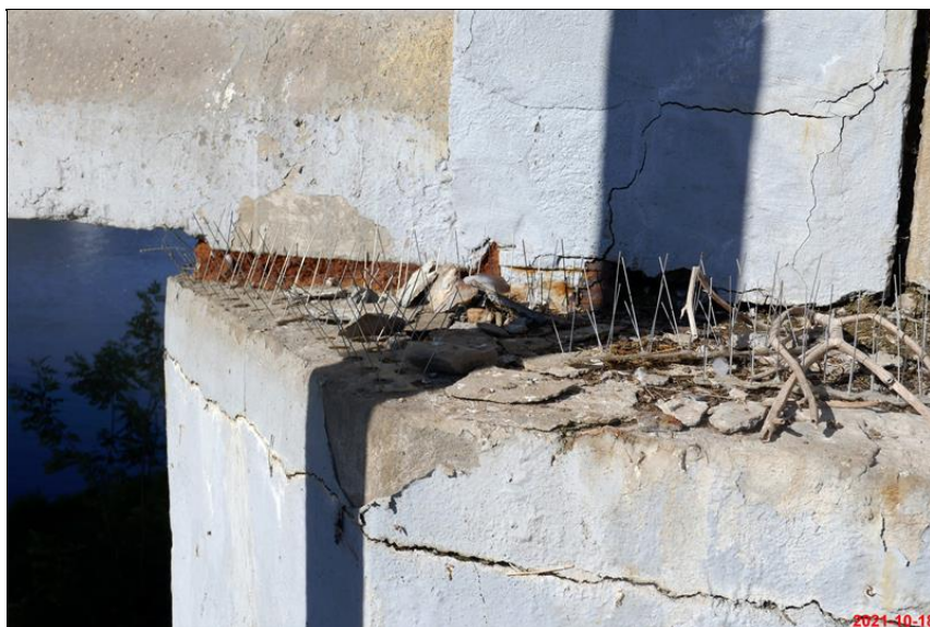
124_trhliny v pilíři.JPG
