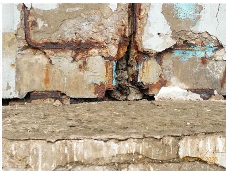
055_P5 dilatace, zleva. Stopy po zatékání a koroze v místě dilatace.jpg
