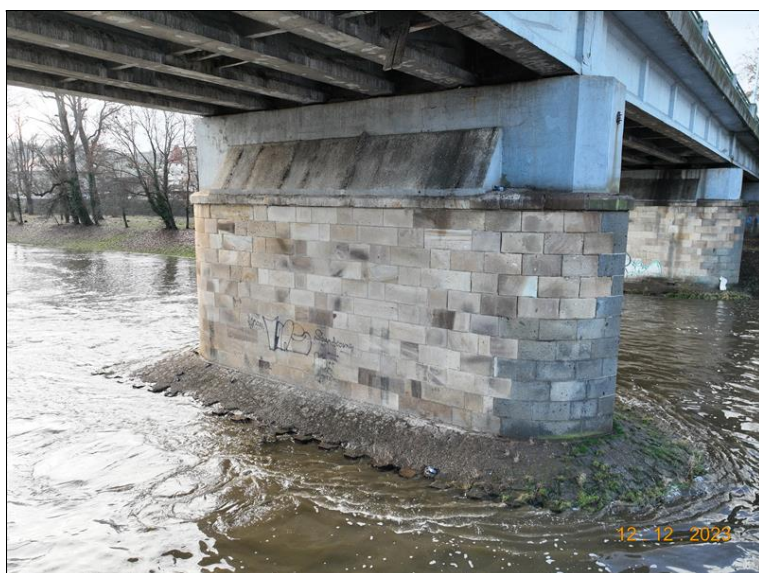
052_P5 po směru staničení. Stopy po zatékání a degradace betonu v horní části úložného prahu.jpg
