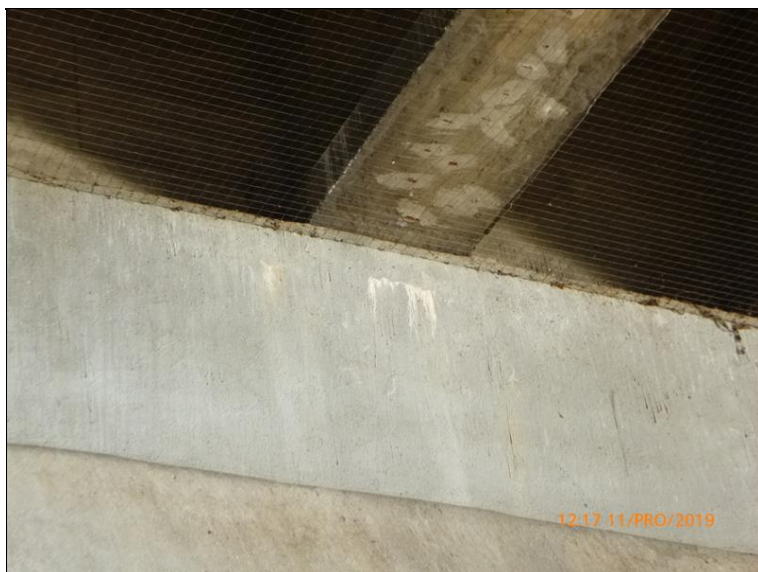
P3 - lokální výluhy pod sanací
