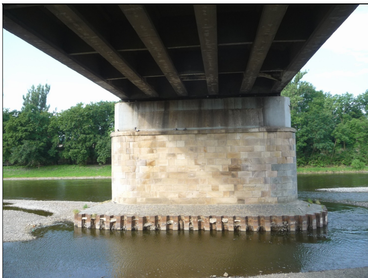
Povodňový proud vytvořil před navodní stranou ochranné štětovnicové obšívky pilíře P4 výmol, za ní došlo k úsazení štěrkovitého náplavu. Výmol zasahuje cca 2 m pod úroveň normálního dna. Korodující štětovnice stále plní ochranou funkci.
