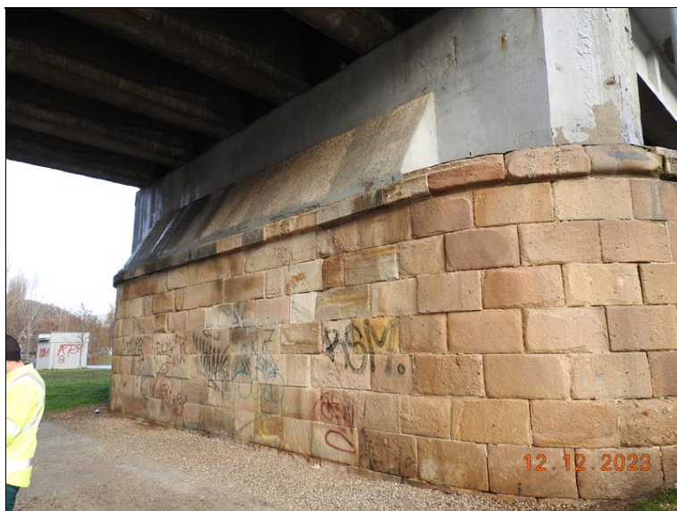
030_P3 proti směru staničení. Zanesení trusem, lokální trhliny a koroze výztuže.jpg
