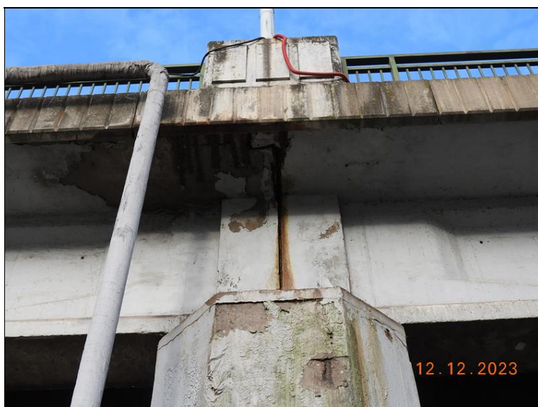
032_P3 dilatace, zleva. Koroze výztuže, stopy po zatékání a separaci krycí vrstvy.jpg
