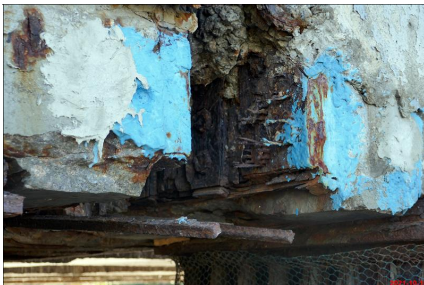
předpánacích kotev zcela chybí.
