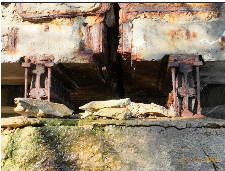
068_P6 ložiska zleva. Rozsáhlá koroze.jpg
