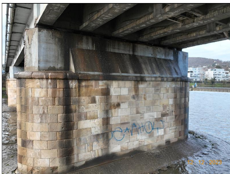
041_P4 po směru staničení. Stopy po zatékání a degradace betonu v horní části úložného prahu.jpg
