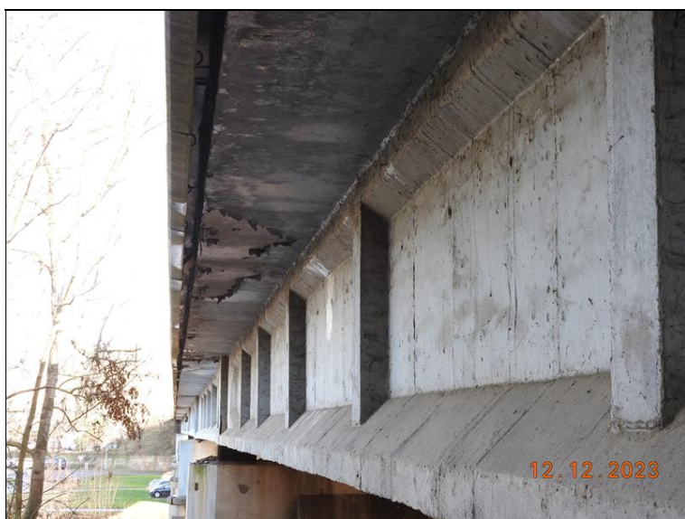
119_Pravý bok NK od OP7. Degradace nátěru.jpg
