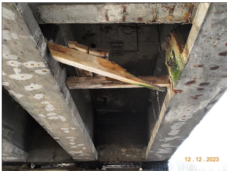
039_Pole č. 3 podhled NK mezi N5 a N6. Rozsáhlá koroze, stopy po zatékání, výluhy a biodegradace.jpg
