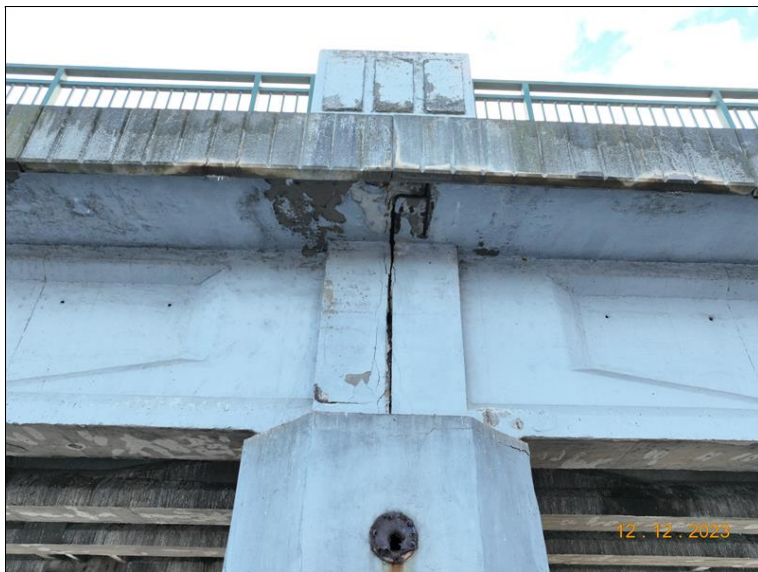
057_P5 dilatace, zprava. Degradace betonu a porušená krycí vrstva.jpg
