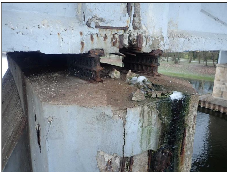
Pil 4 - pravý bok. Značné zatékání, degradace výztuže.
