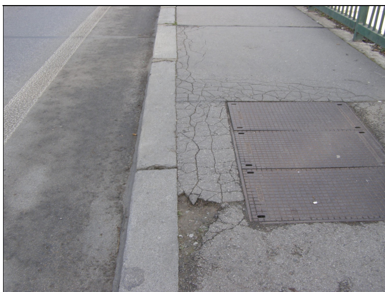
Sítě trhlin v živičném povrchu na levém předmostí OP2
