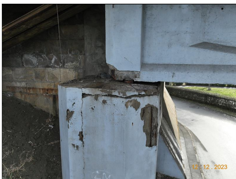
008_Úložný práh OP1 zprava. Rozpad úložného prahu v horní části.jpg
