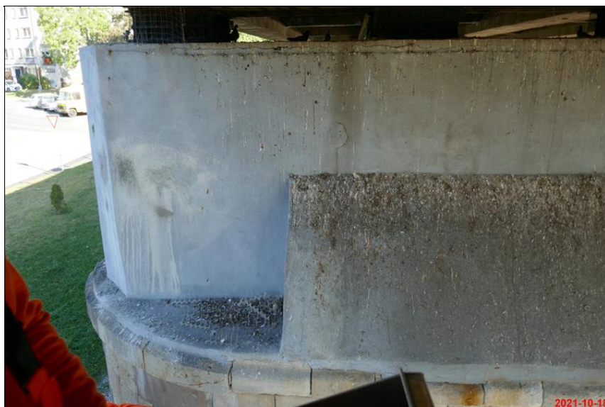
127_znecisteni_trhlina_odstr kryci vrstva.JPG
