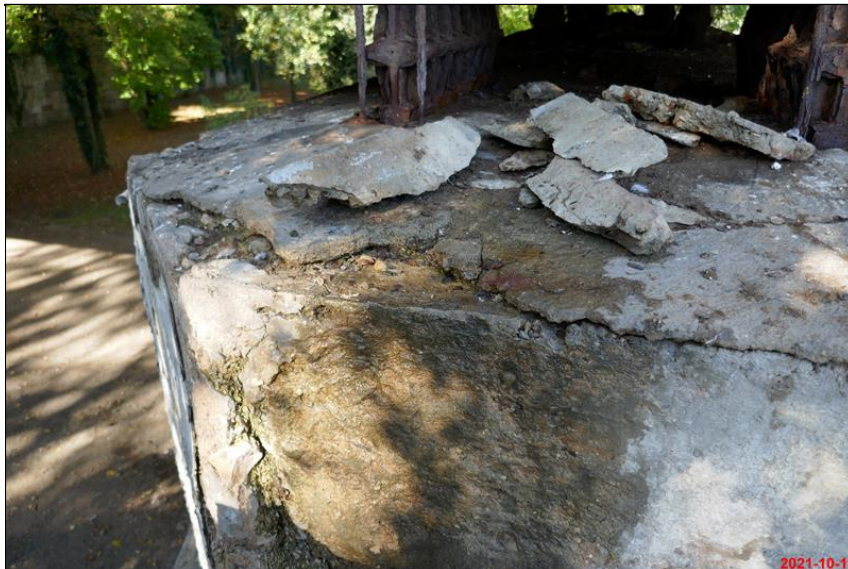
166_degradace povrchu P6.JPG
