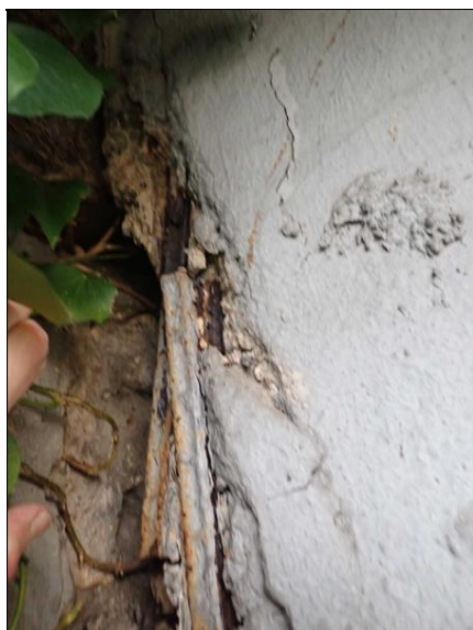
Neprobetonovaná korodující výztuž na čele betonového nosníku.
