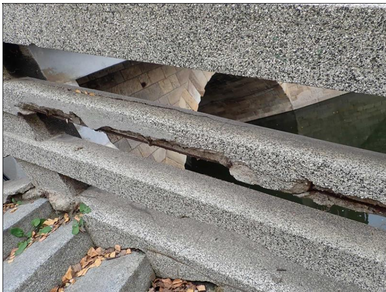
Zábradlí schodiště u opěry 2 vlevo - odpadávají kusy betonu.
