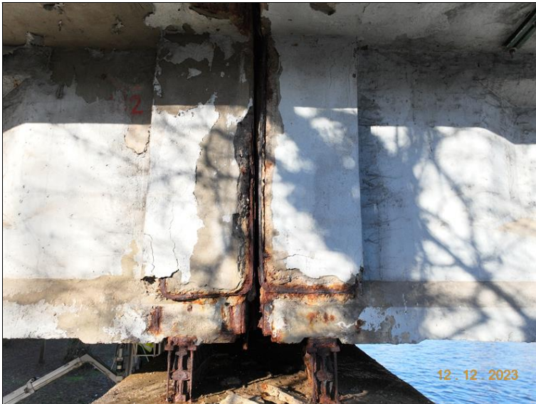
067_P6 dilatace, zleva. Stopy po zatékání a koroze v místě dilatace.jpg
