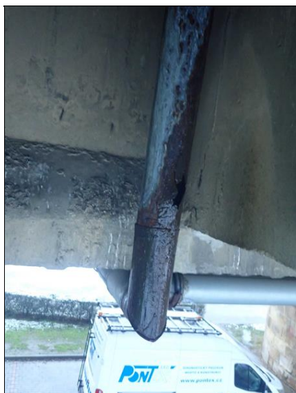
Prokorodovaná trubka odvodnění, zatékání okolo trubky na NK.
