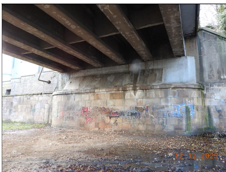
080_OP7. Stopy po zatékání, separace krycí vrstvy, degradace spárování a podélná trhлина v horní části.jpg
