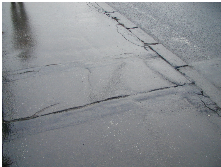
Otevřené pracovní spáry podél dilatačního závěru v chodníku.
