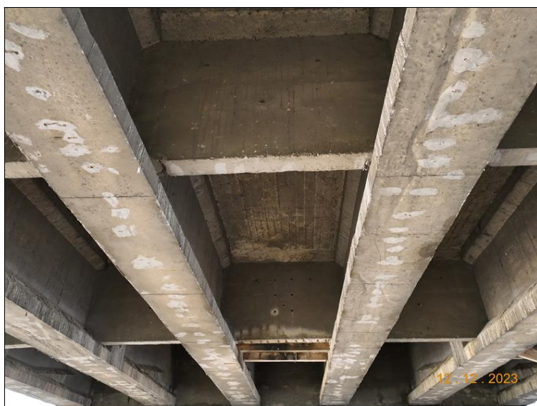
037_Pole č. 3 podhled NK mezi N3 a N4. Degradace betonu a koroze sanované výztuže.jpg
