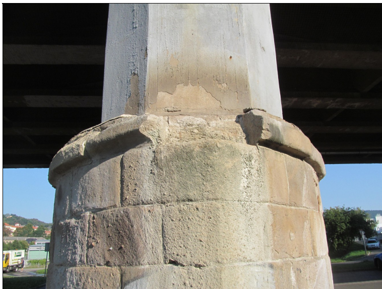
Chybějící kámen na povodní straně pilíře P3.
