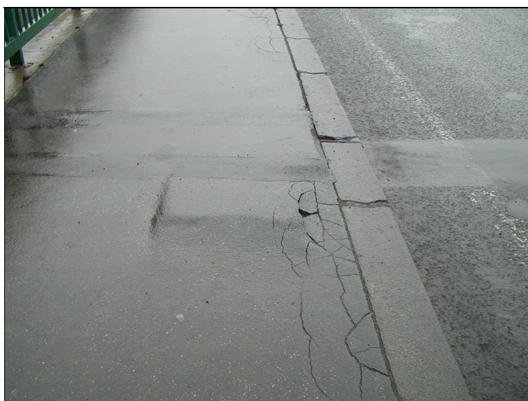
Odlamování krytu chodníku podél obruby, resp. v okolí poklopu šachty inženýrských sítí.
