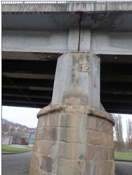
Pilíř 2 - značné zatékání dilatační spárou, degradace betonu pilíře.
