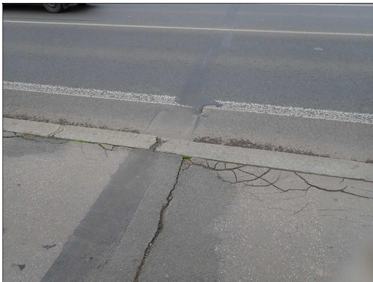
Dilatační závěr nad piliřem 4. Je odtržený, v okolí trhliny, zejména v chodníku.
