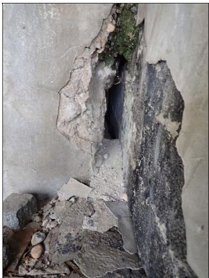
Pohled na dilatační spáru a úložnou spáru. Množství odpadlého degradovaného betonu.
