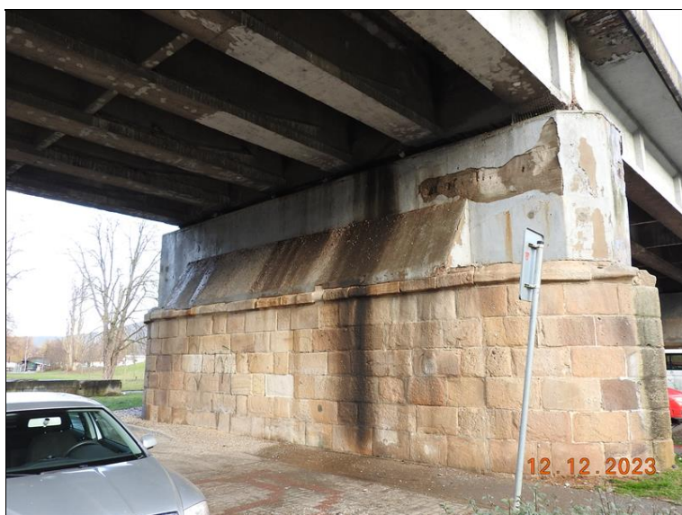
016_P2 proti směru staničení. Degradace krycí vrstvy, koroze výztuže, stopy po zatékání a vodorovná trhлина v horní části úložného prahu.jpg
