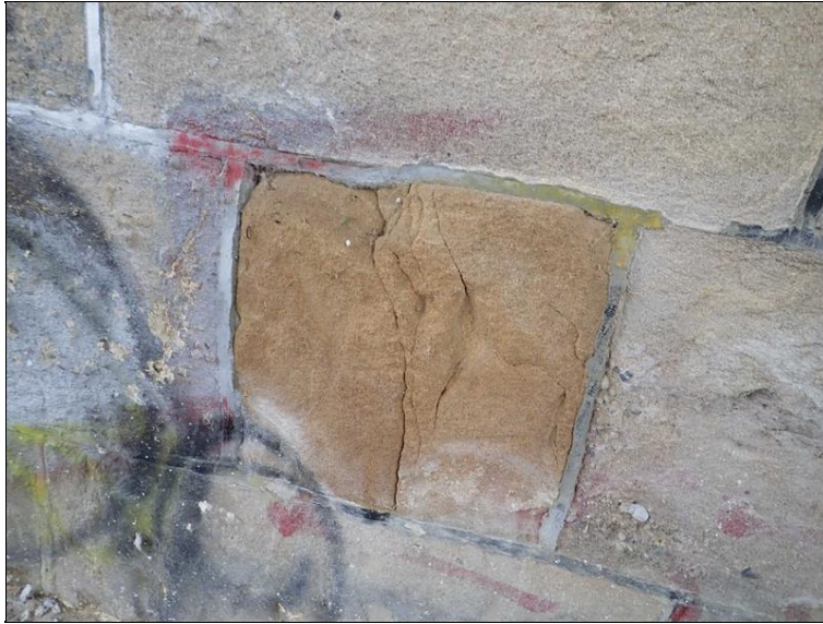
Pilíř 2 - značné zatékání dilatační spárou, degradace betonu pilíře.
