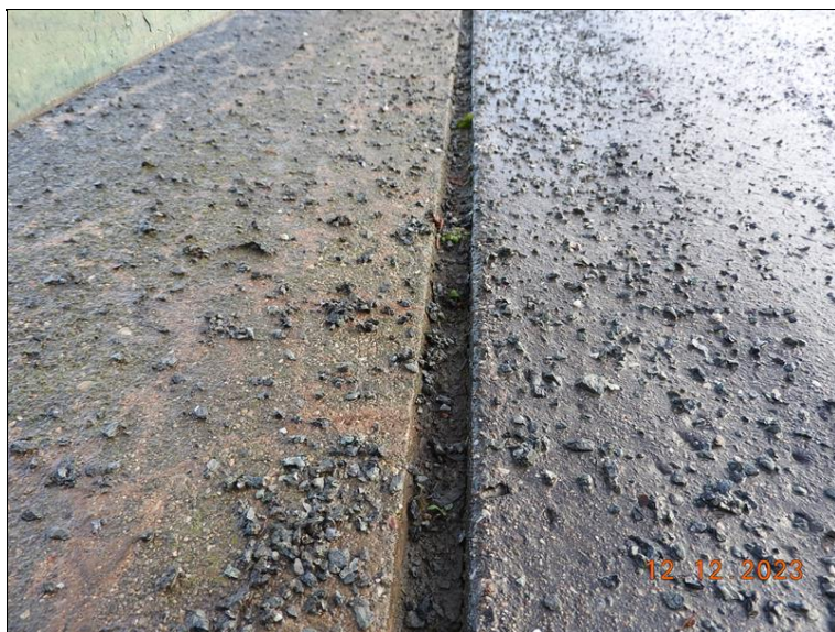
099_Pravý chodník - detail. Degradace těsnící zálivky, lokálně vegetace.jpg
