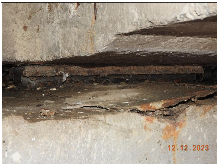
085_OP7 ložisko č.4. Důlková koroze, odlupující se úložný práh.jpg
