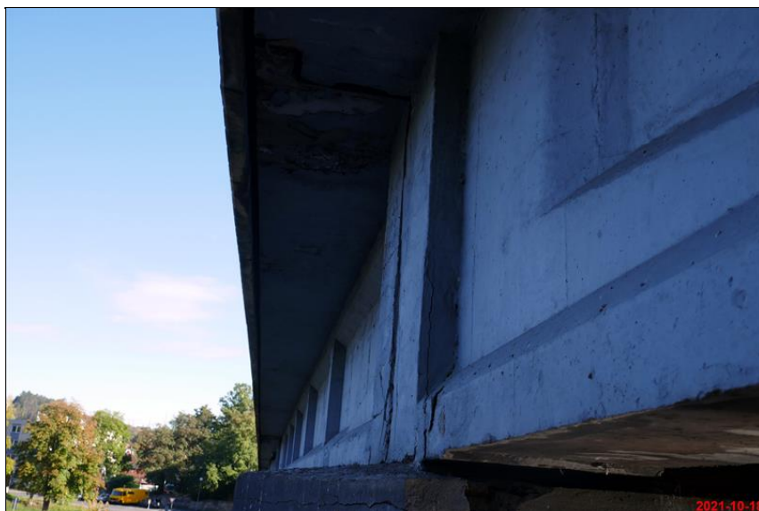
242_trhliny v NK nad pilířem P4.JPG
