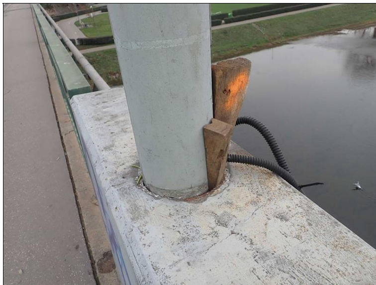
Vyklánějící se lampa VO byla provizorně zajištěna dřevěnými klíny.
