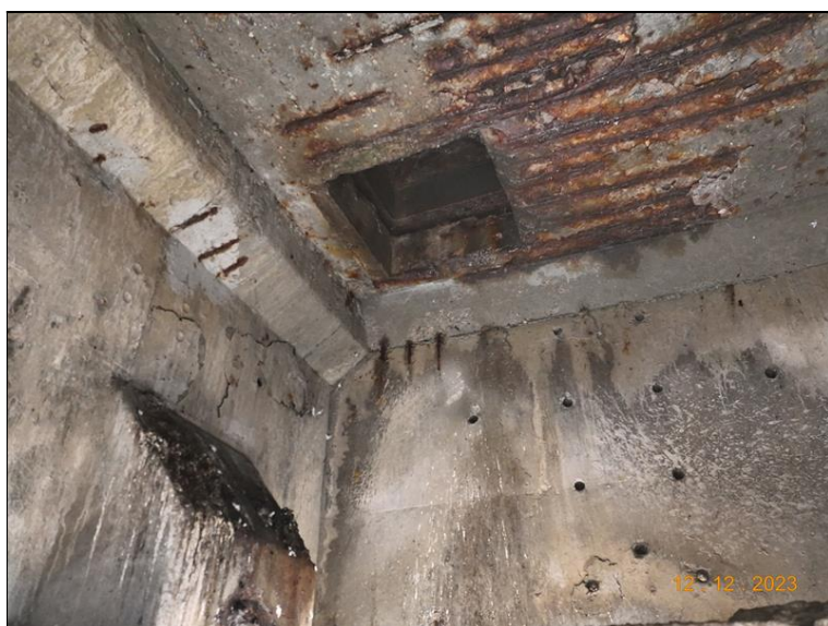
062_Pole č. 5 pohled NK mezi N5 a N6. Degradace betonu a koroze výztuže.jpg
