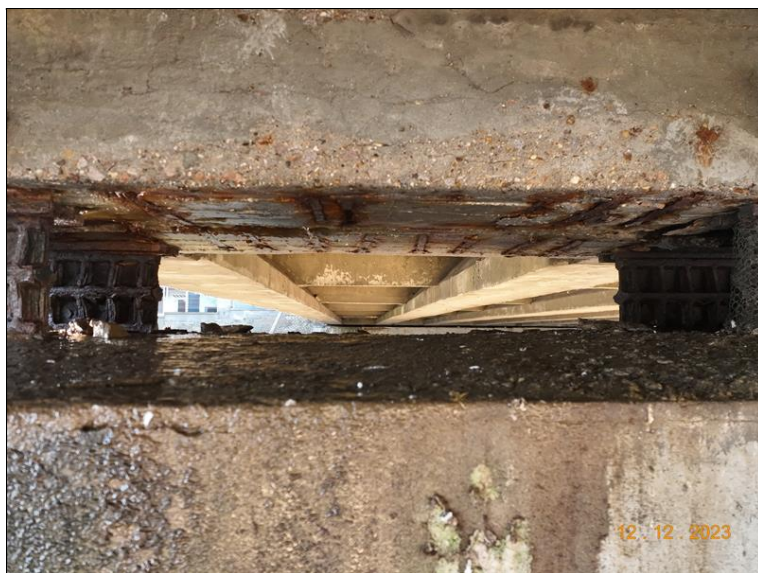
076_Podhled nosné konstrukce nad P6. Degradace betonu a koroze výztuže.jpg
