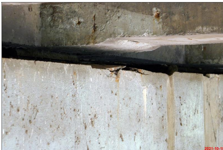
175_degradace betonu na OP7.JPG
