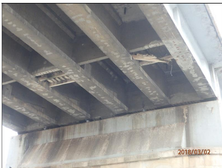
Rozpad dřevěných lávek mezi nosníky.
