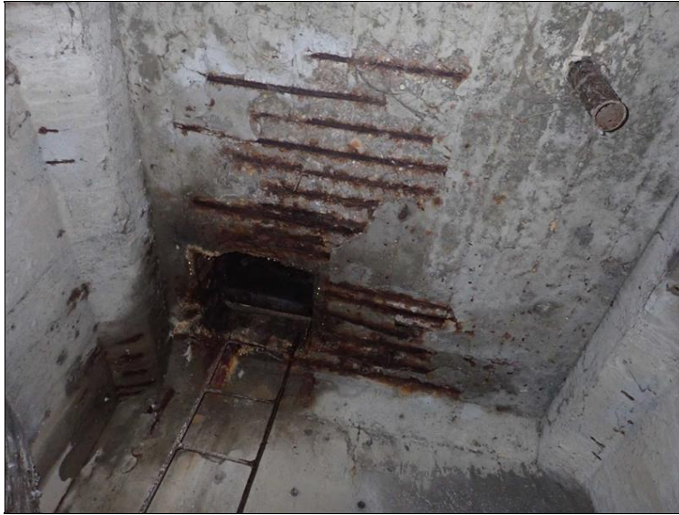
Zatékání kolem otvorů v desce mostovky (vedou na lávky ke stálému zařízení). Koroze výztuže s oslabením. Pole 4.
