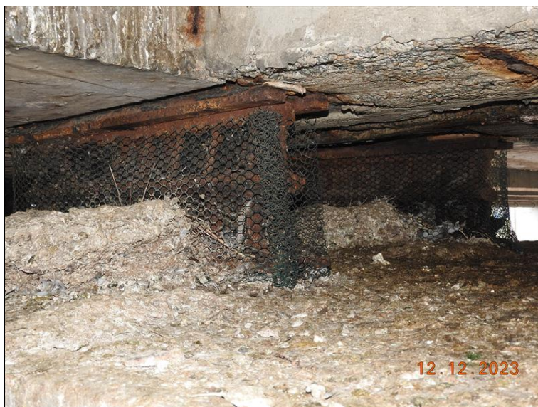
024_P2 ložisko č. 5. Rozsáhlá koroze, zanesení trusem.jpg
