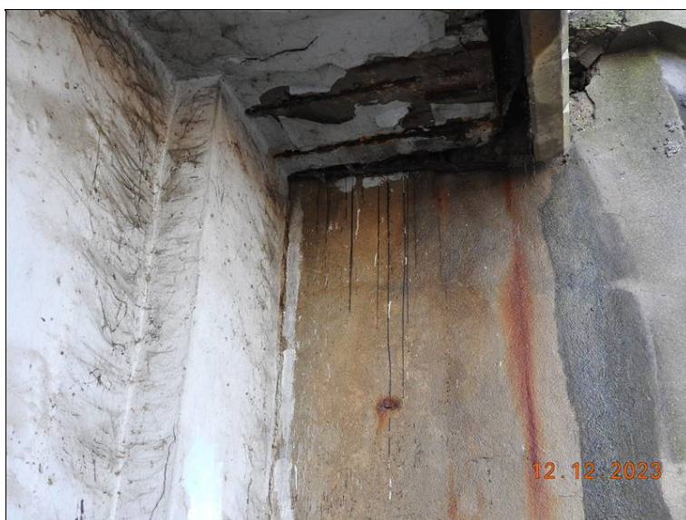
088_OP7 ZZ, vpravo. Stopy po zatékání, koroze výztuže a degradace betonu.jpg
