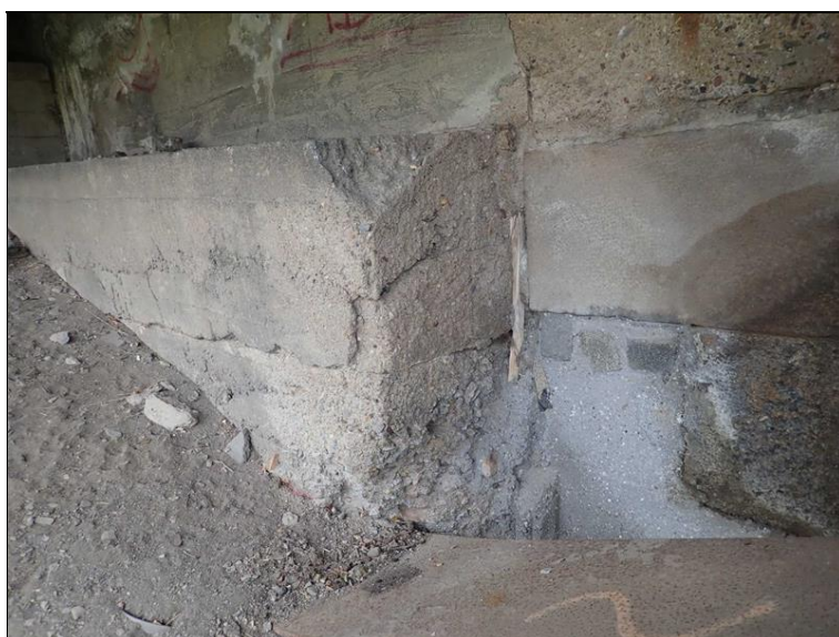
Hlubková degradace betonu opěry 1.
