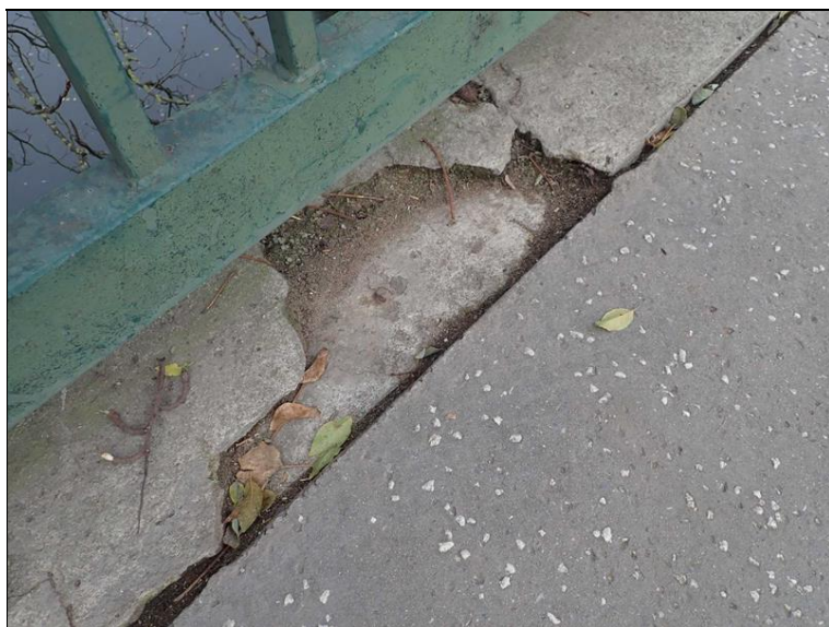
Povrchová vrstva betonu římsy se rozpadá v délce několika metrů.
