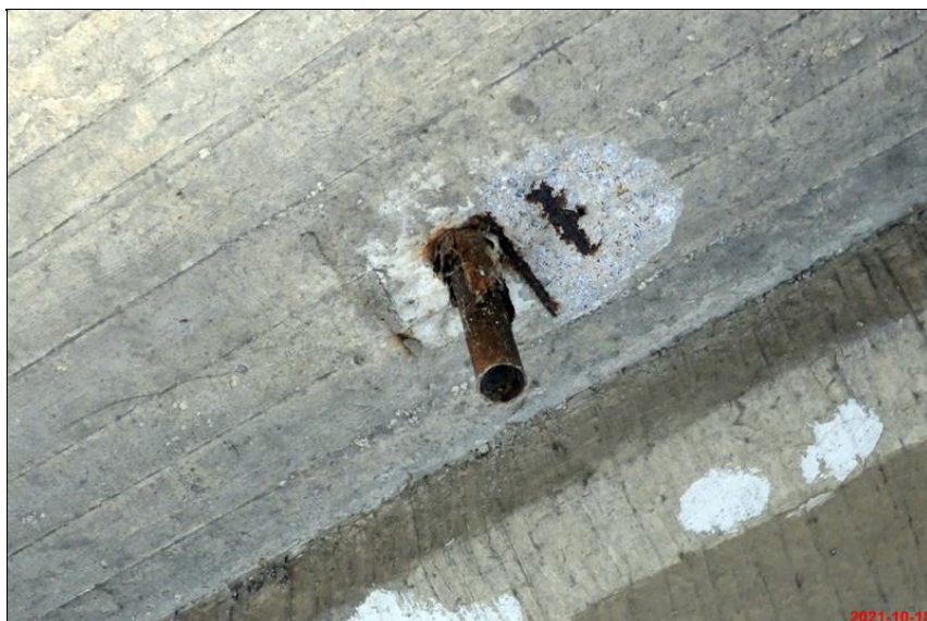
409_koroze odv trubicky.JPG
