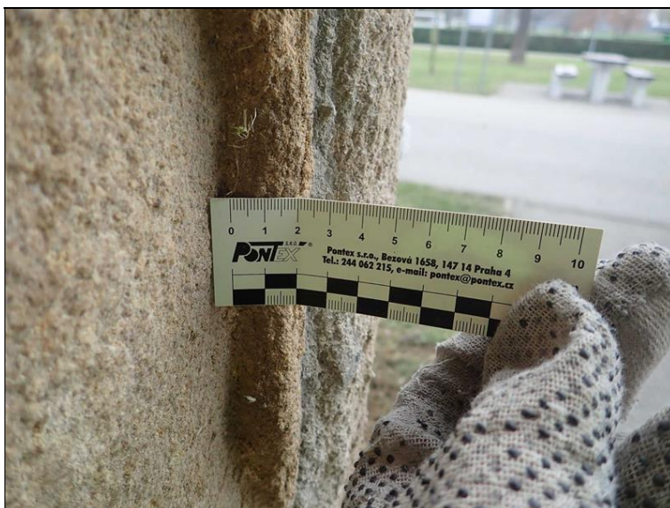
Pilíř 2 - lokálně hloubková degradace obkladního zdiva.
