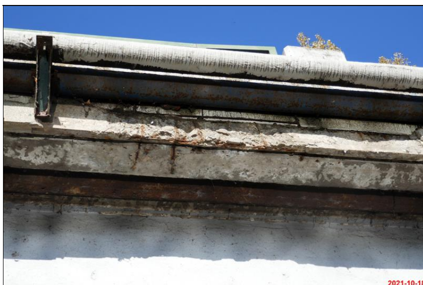
42_degradace betonu rimsy.JPG
