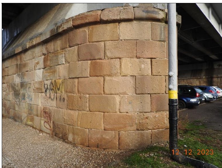
031_P3 spodní část degradace spárování - opakovaný jev u všech pilířů.jpg
