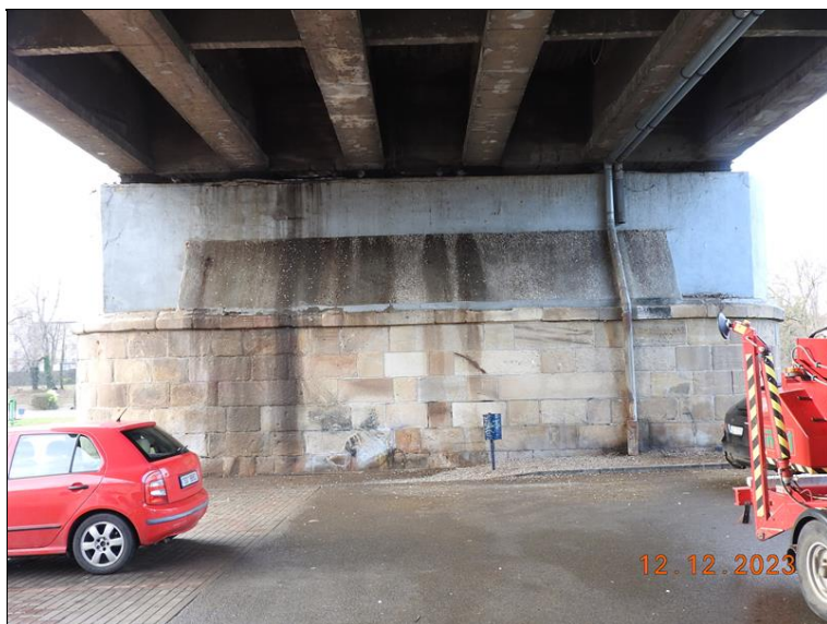
015_P2 po směru staničení. Degradace krycí vrstvy, koroze výztuže, stopy po zatékání a vodorovná trhлина v horní části úložného prahu.jpg
