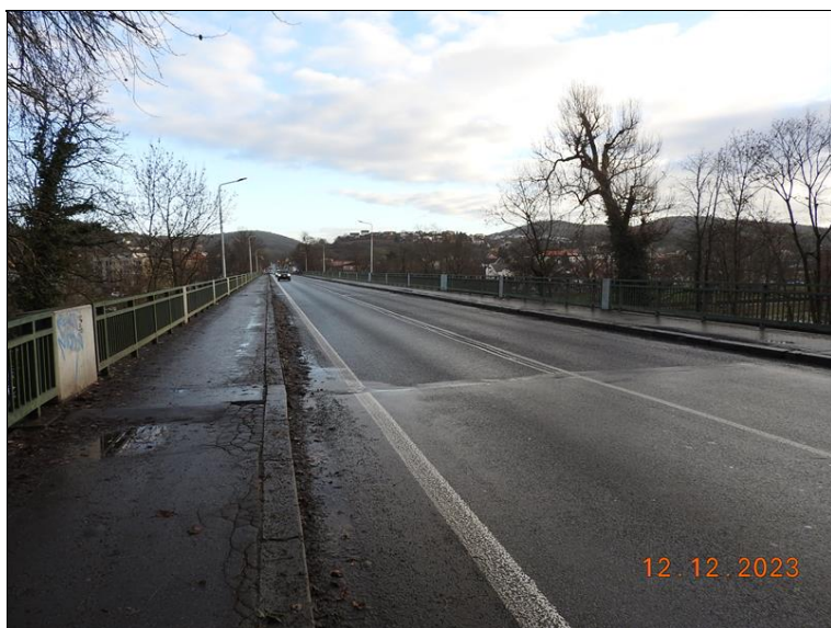
001_Šířkové uspořádání na mostě pohled proti směru staničení. chybí ev. číslo a SDZ.jpg
