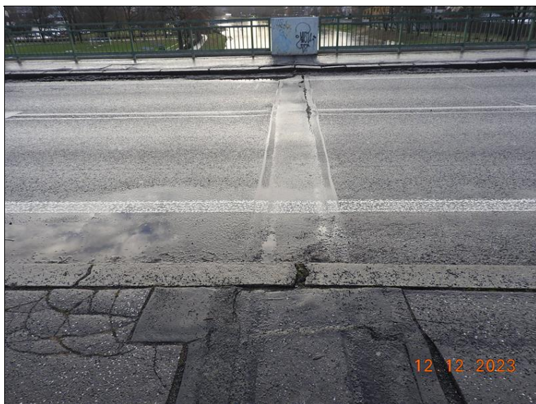
106_MZ P4. Příčná trhlina.jpg
