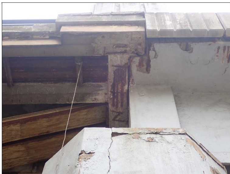
Svislá trhlina v opěře 1 vpravo, vrstevnatá koroze konzoly rozšíření opěry.
