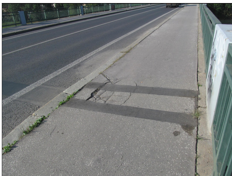
Trhliny v chodníku v místě podpovrchového mostního závěru.
