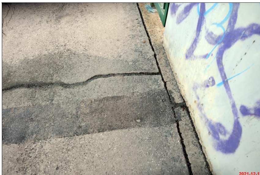
428_nezatesnene trhliny v miste dilatace.JPG
