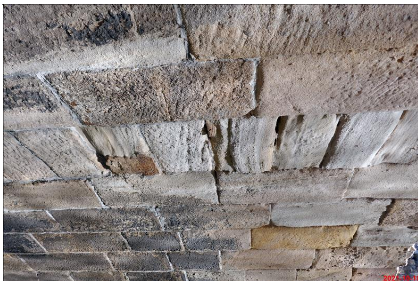
34_degradace kamenu zdiva.JPG
