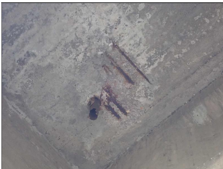
Zatékání a koroze výztuže u odvodňovačů.
