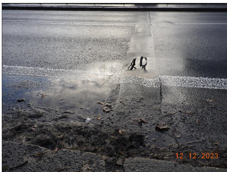
113_MZ OP7 - detail. Zvlnění vozovky, neodtékající voda.jpg
