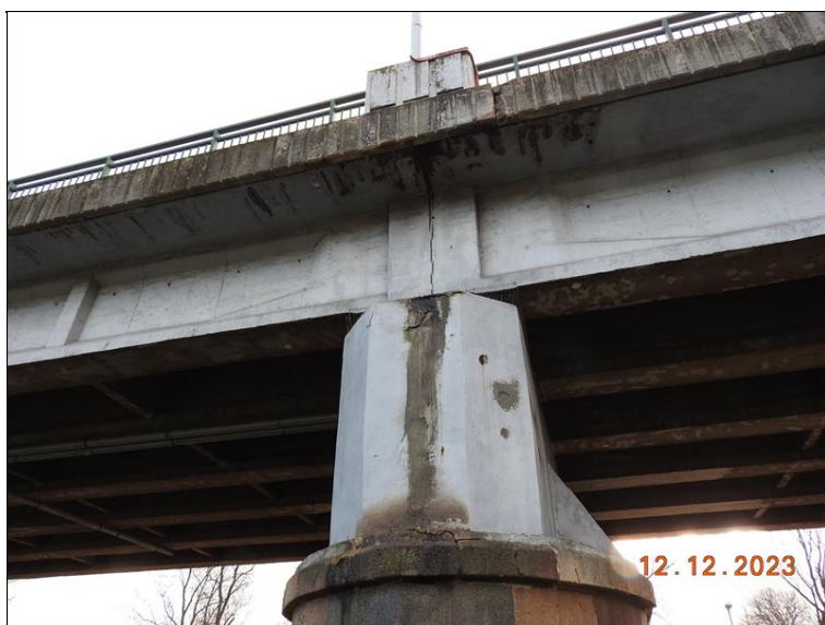
019_Dilatace nad P2, vpravo. Stopy po zatékání, separace krycí vrstvy a koroze výztuže.jpg
