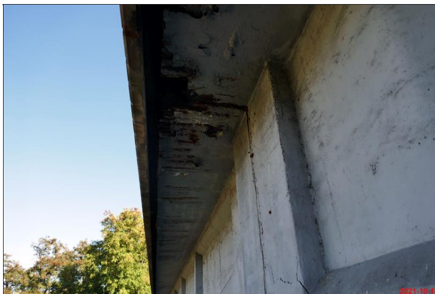
226_degradace podhledu NK.JPG
