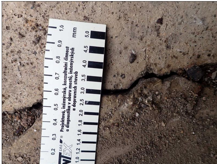
Trhlina v úložném prahu opěry 1 vpravo.
