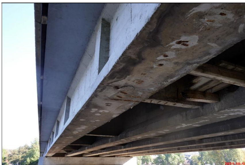
255_koroze_stopy po zatekání.JPG
