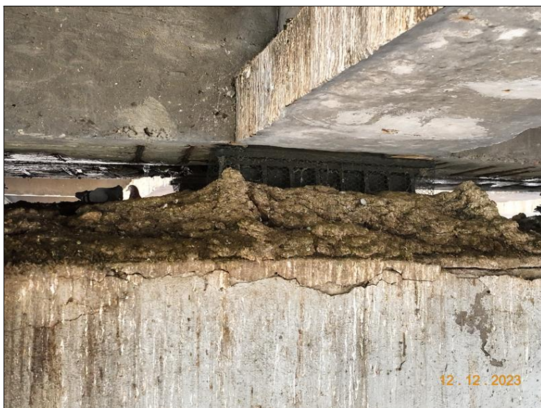
046_P4 ložisko č. 4. Zanesené trusem a rozsáhlá koroze.jpg
