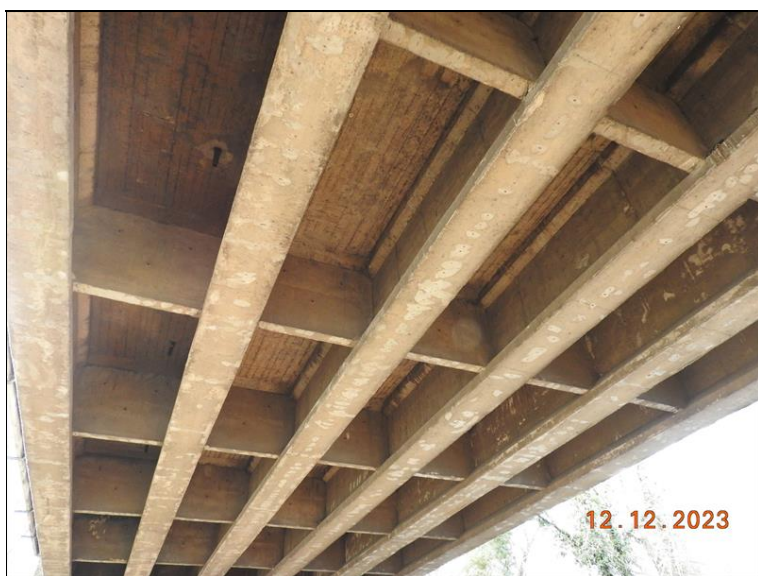
077_Pole č. 6 podhled NK. Stopy po zatékání, degradace betonu a koroze výztuže.jpg
