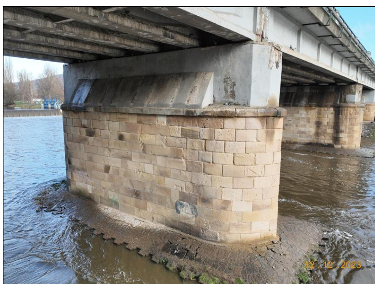
053_P5 proti směru staničení. Stopy po zatékání a degradace betonu v horní části úložného prahu.jpg
