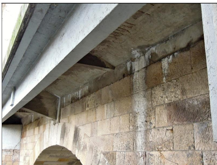
průsaky, koroze výztuže na spodním líci mostovky rozšíření
