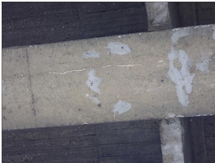
Výluh v trase předpínacího kabelu - pole 6.
