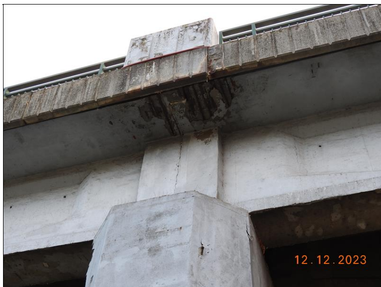
033_P3 dilatace, zprava. Separace krycí vrstvy, koroze výztuže.jpg
