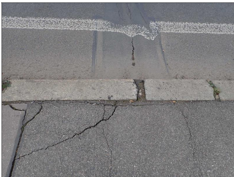
Dilatační závěr nad pilířem 2. Je odtržený, v okolí trhliny, zejména v chodníku.
