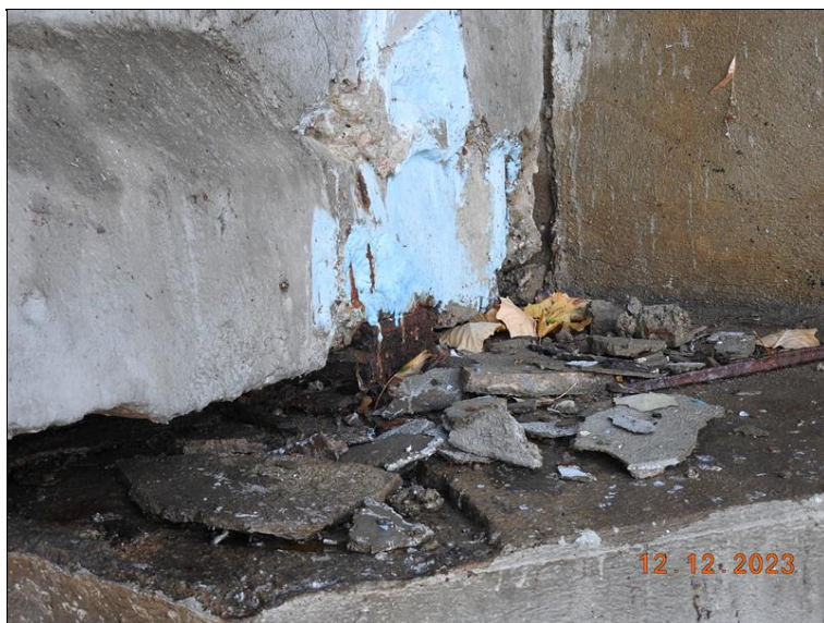
087_OP7 ložisko č. 6, zprava. Rozsáhlá koroze, stopy po zatékání.jpg
