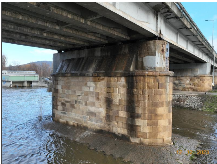
042_P4 proti směru staničení. Separace krycí vrstvy, koroze betonu, stopy po zatékání a degradace betonu v horní části úložného prahu.jpg
