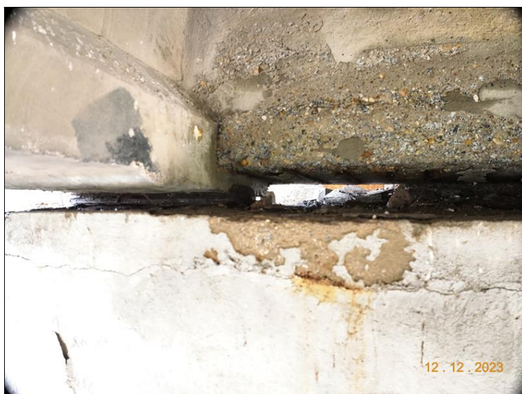
010_OP1 ložisko č. 6. Rozsáhla korozí.jpg
