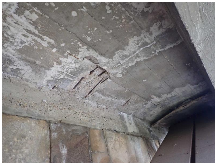
Sanace nad Pil 5: v tloušťce cca 3 cm brzo odpadne vlivem korozních produktů výztuže. Nad Pil 4 i jinde již odpadla.
