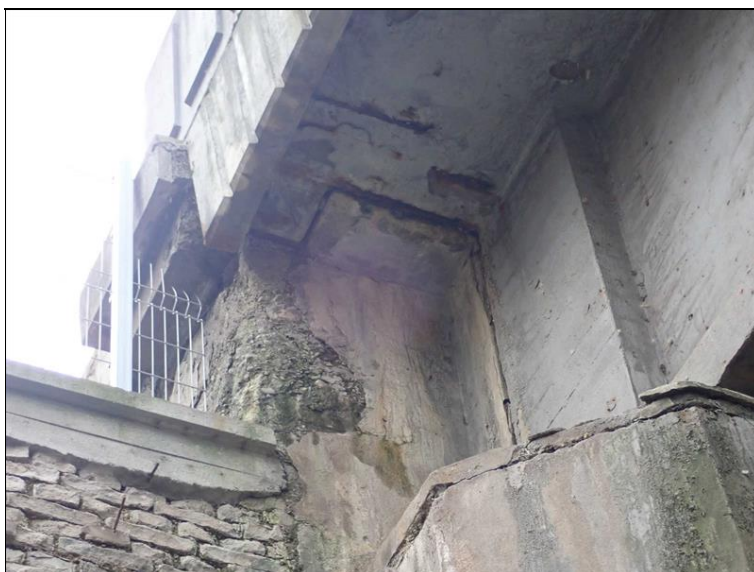
Levé křídlo opěry 7 - degradace betonu, oddělení horní vrstvy betonu úložného prahu. Zatékání dilatační sparou.
