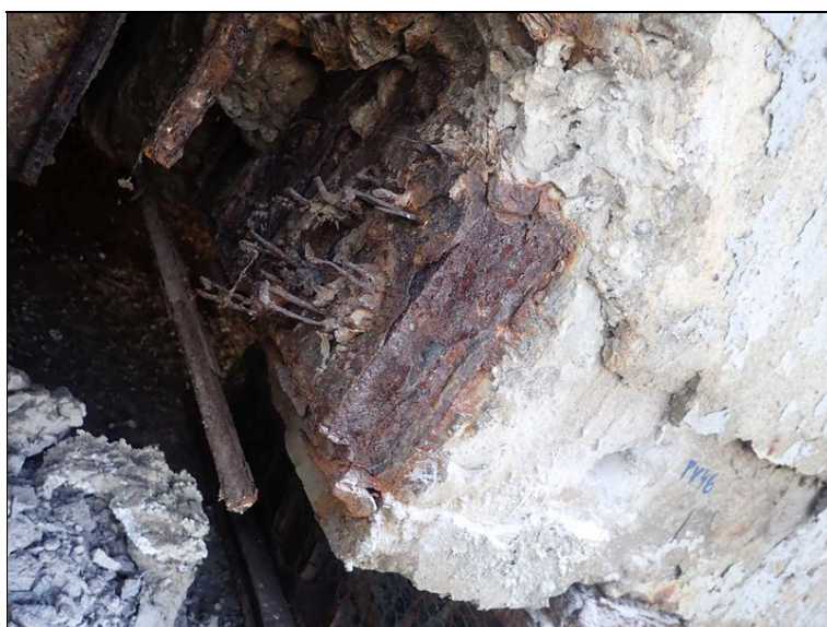
Stav kotvy podélného předpětí.
