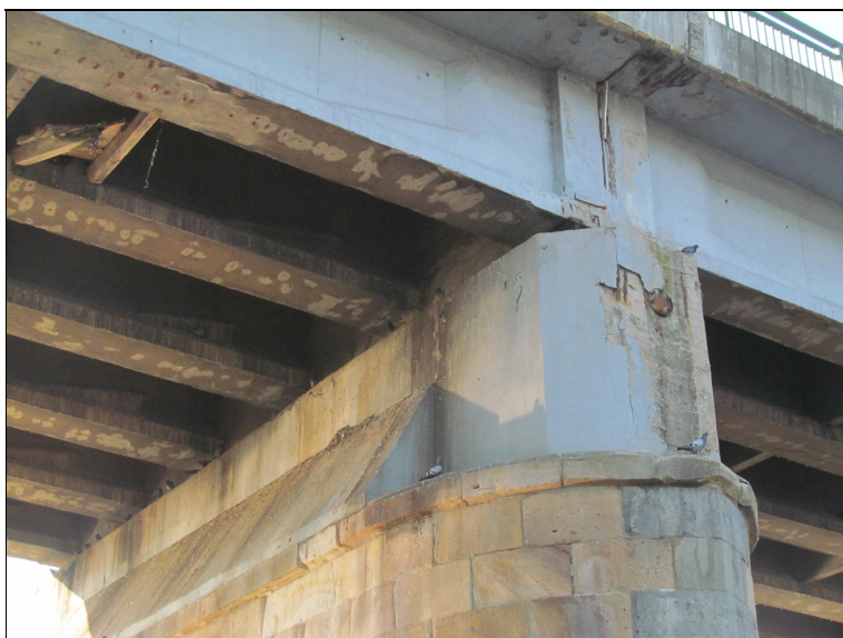
Typická závada, na bok stativa pilíře zatékání netěsným mostním závěrem, separace omítky, degradace betonu.
