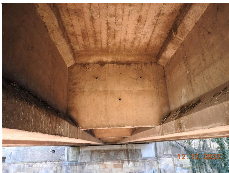
079_Pole č. 6 podhled NK mezi N3 a N4. Zanesení trusem.jpg
