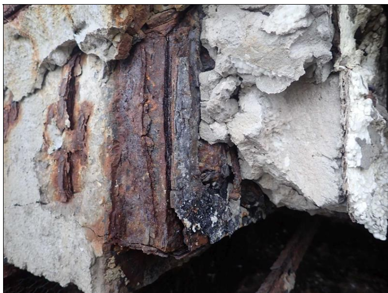
Stav kotev podélného předpětí: vrstevnatá koroze, viditelné dráty mají oslabení až 100 %.
