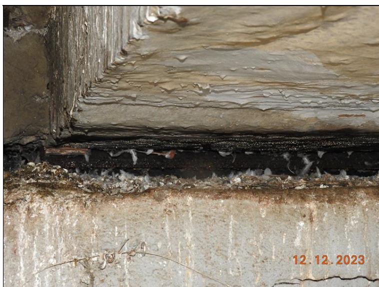
035_P3 ložisko č. 5 . Rozsáhlá koroze, zanesení trusem.jpg
