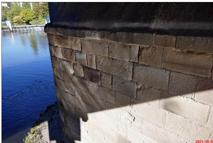
142_degradace kamenu zdiva na pilíři P4.JPG
