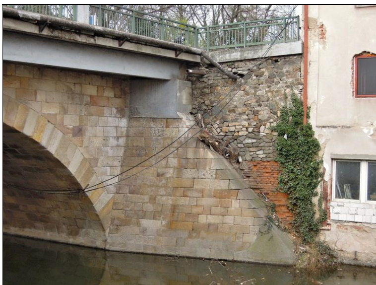
OP1, LS - narušené zdivo - kamenné i cihelné
