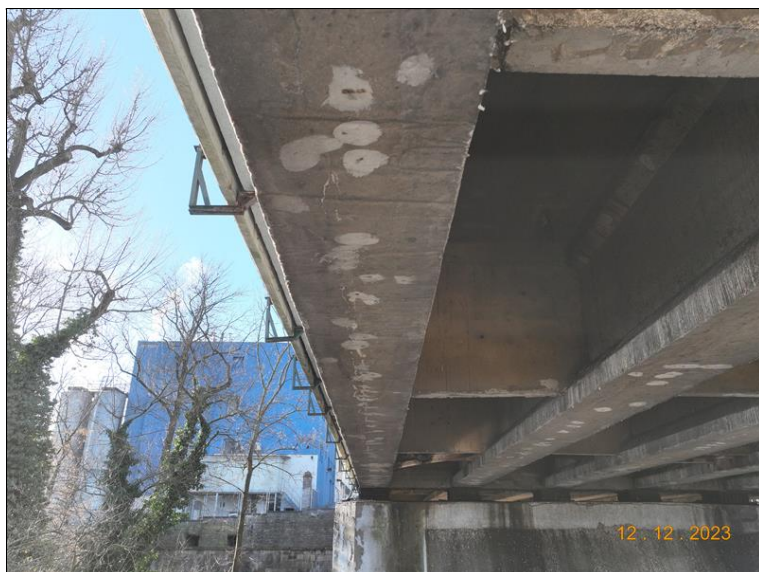
060_Pole č. 5 pohled NK - N1. Výskyt podélných trhlin v dolní pásnici nosníku.jpg
