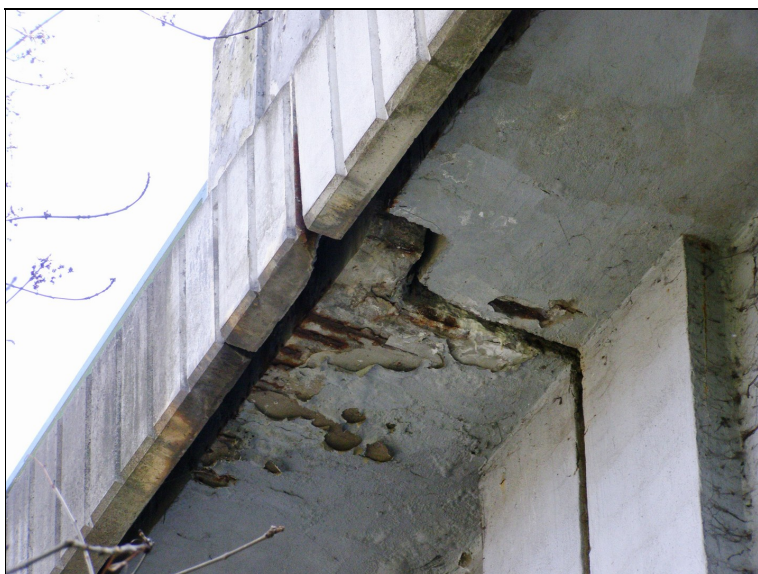
Dilatační spára - poruchy NK, římsy v důsledku zatékání
