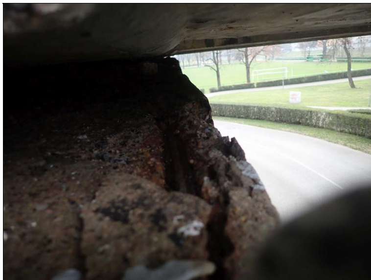
Úložný práh - blíží se odpadnutí značného kusu betonu na podchozí komunikaci. Hrozí prakticky po celé délce prahu (na jistých úsecích již odpadl).
