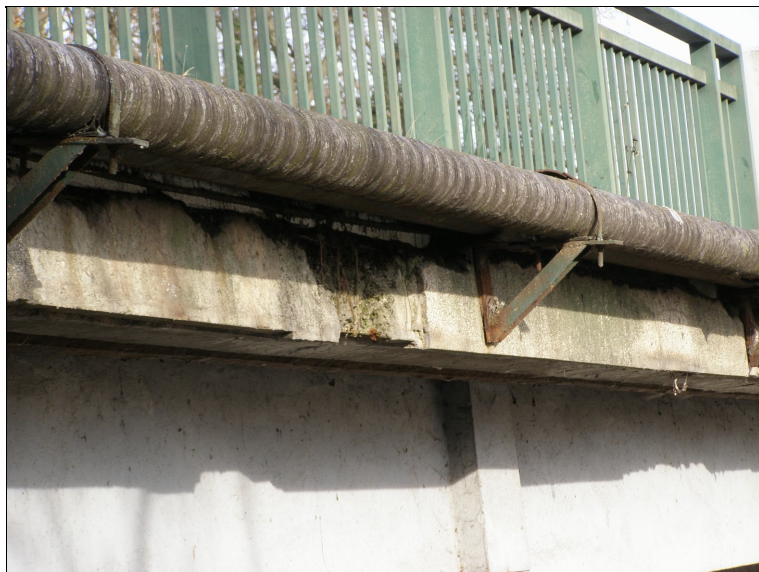
Degradace betonu na boku levé římky.
