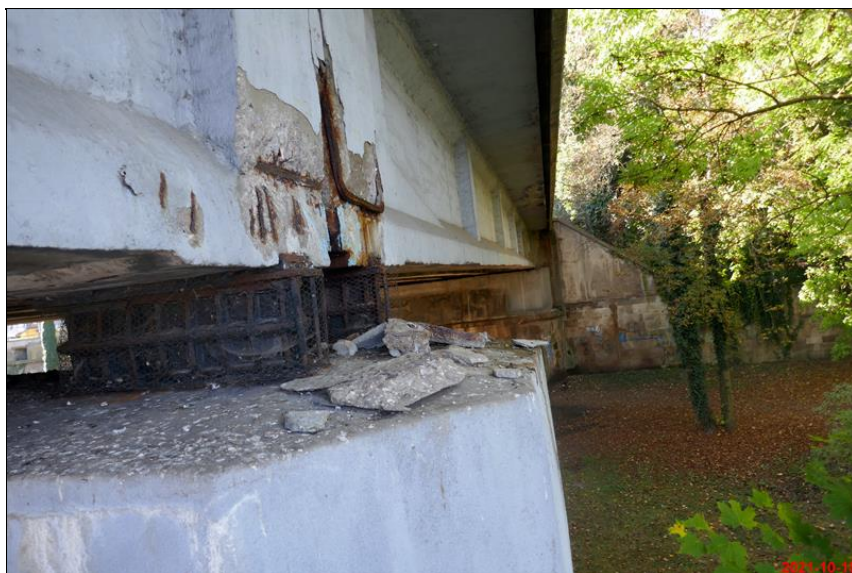
150_degradace betonu na P5.JPG
