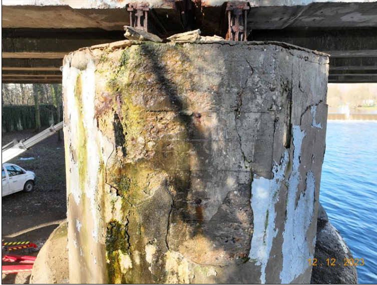
066_P6 zleva. Degradace betonu, stopy po zatékání a působení biodegradace.jpg
