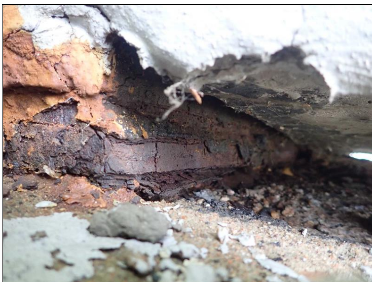
Ložisko na opěře 1 vpravo - vrstevnatá koroze.
