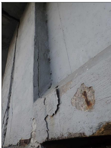
Sanace nad Pil 5: v tloušťce cca 3 cm brzo odpadne vlivem korozních produktů výztuže. Nad Pil 4 i jinde již odpadla.
