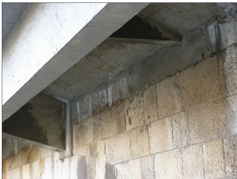
Průsaky s výluhy mezi rozšířením a klenbou.
