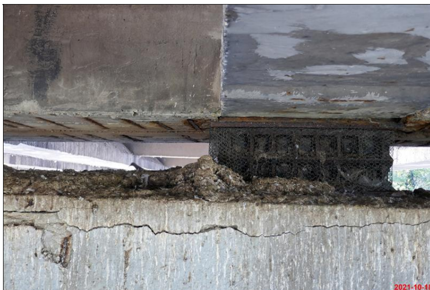
139_vodorovna trhlina v uloženém prahu P3.JPG
