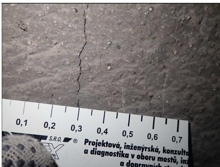
V trámech rozšíření jsou relativně pravidelně svislé trhliny šířky 0.3 mm. Bylo nedestruktivně zjištěno, že pod těmito trhlínami je vždy svislý prut výztuže, počíná tak korodovat.
