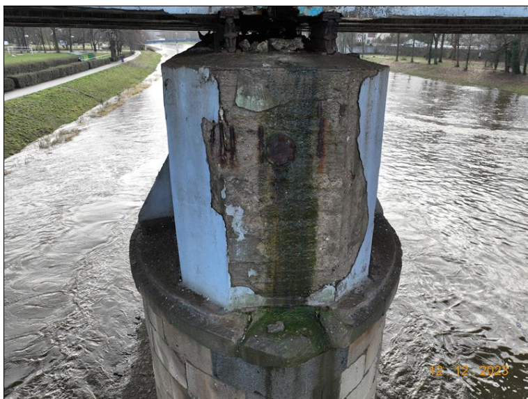
043_P4 zprava. Degradace betonu, koroze výztuže, stopy po zatékání a působení biodegradace.jpg
