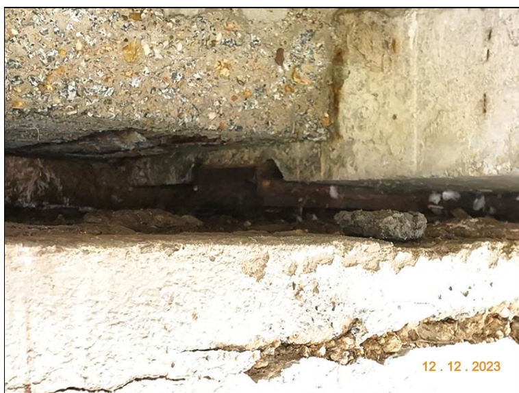
011_OP1 ložisko č. 5. Rozsáhla korozí.jpg
