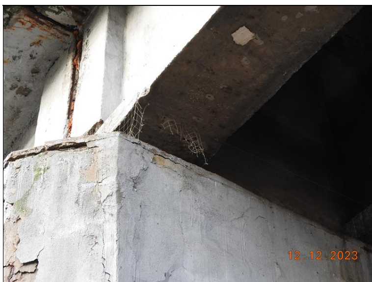
017_P2 - detail. Chybí ochranná síť proti ptactvu - typická závada.jpg
