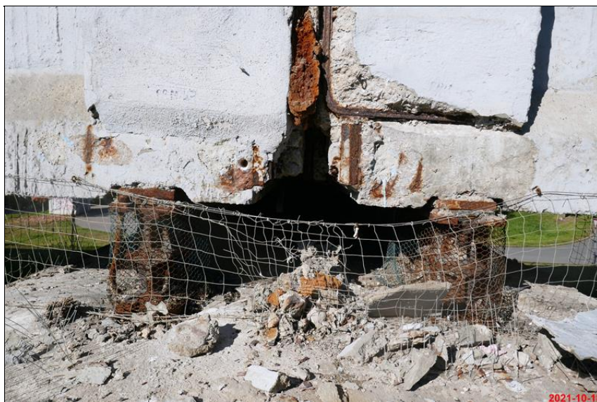
227_degradace kotevnic cel_ložisek.JPG
