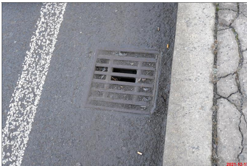
431_zaneseny odvodnovac.JPG
