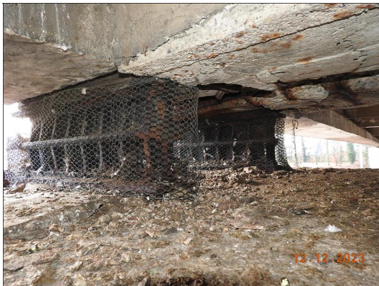
021_P2 ložisko č 1. Rozsáhlá korozie.jpg
