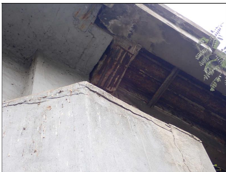
Konzoly opěry (rozšíření chodníkové části u opěry 1 vlevo) - výztuž vrstevnatě koroduje, rozpadá se.
