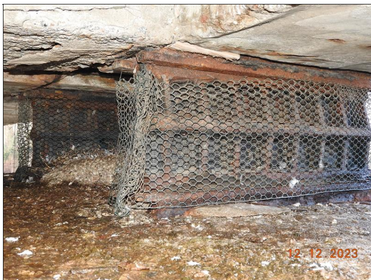
025_P2 ložisko č. 6. Rozsáhlá koroze, zanesení trusem.jpg
