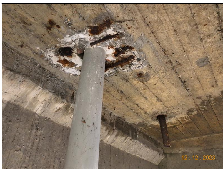
038_Pole č. 3, odvodnění. Stopy po zatékání a koroze výztuže.jpg
