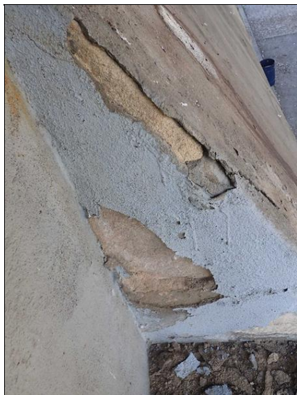
Šikminy spodní stavby jsou kamenné, opatřené omítkou, která odpadá.
