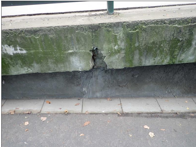
Levé křídlo opěry 7 - šikmá trhlina, odpadlý beton římsy..
