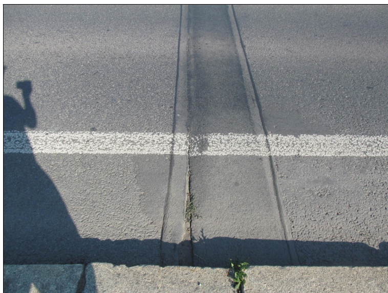
Otevřená spára u mostního závěru na styku s vozovkou.
