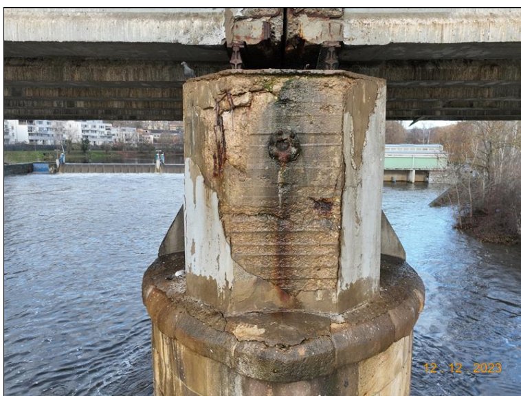
044_P4 zleva. Degradace betonu, koroze výztuže, stopy po zatékání.jpg
