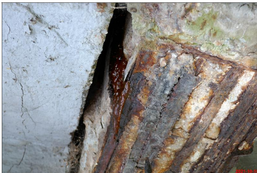
412_koroze odvodneni.JPG
