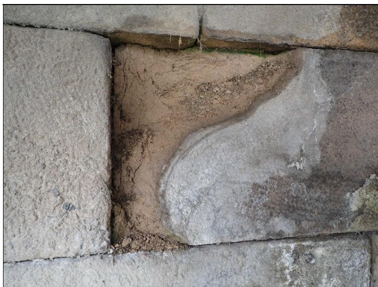
Jiný blok - hloubková degradace bloku.
