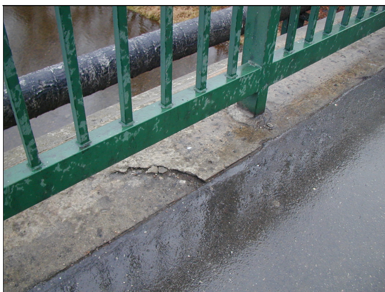
Odlupující se krycí vrstva na horním líci římsy.
