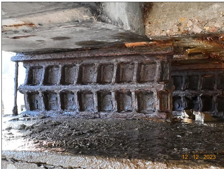
072_P6 ložisko 1. Rozsáhlá koroze.jpg
