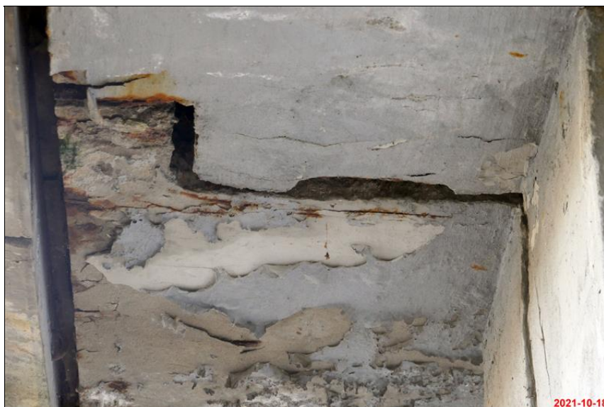
244_degradace betonu v miste dilatace.JPG
