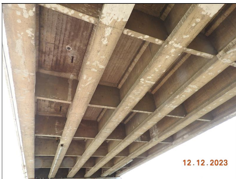
026_Pole č. 2 podhled nosné konstrukce. Stopy po zatékání, separace krycí vrstvy a koroze výztuže.jpg
