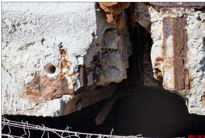
předpánacích kotev zcela chybí.
