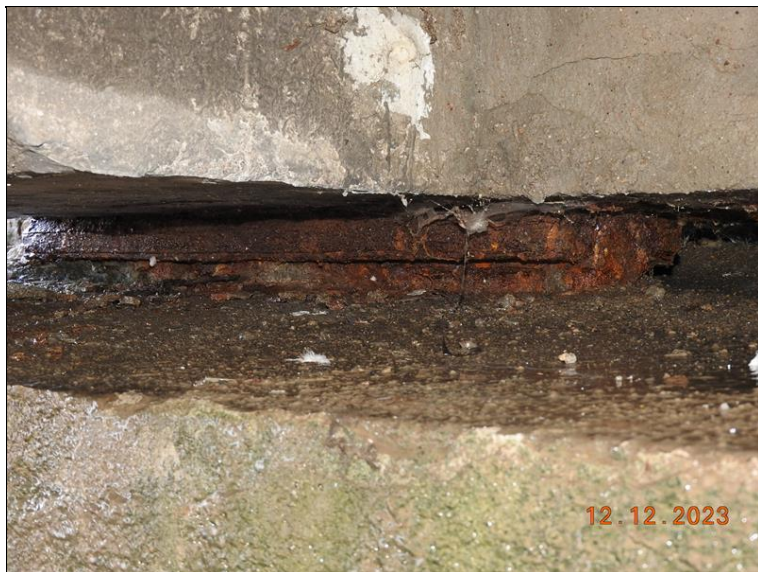
084_OP7 ložisko č. 1. Rozsáhlá koroze, stopy po zatékání.jpg
