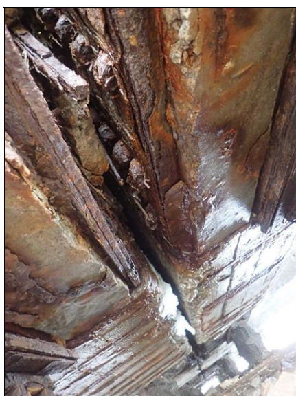
Pohled na dilatační spáru Pil 5: Odpadlé kusy betonu, koroze výztuže, zatékání.
