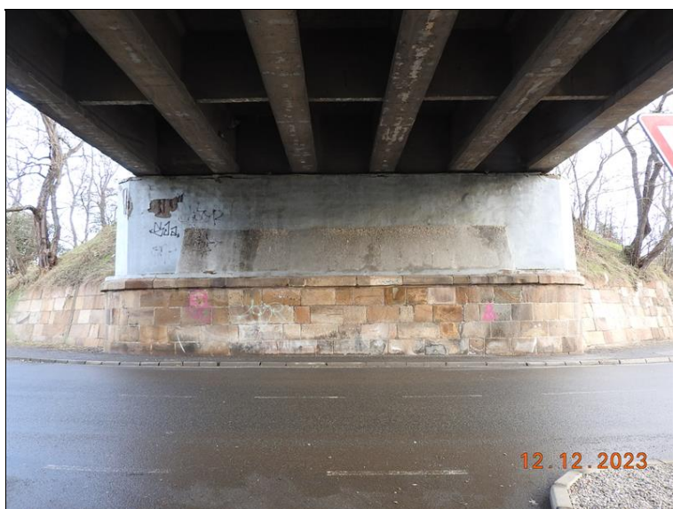
004_OP1. Degradace krycí vrstvy, koroze výztuže, vodorovná trhлина v horní části úložného prahu.jpg
