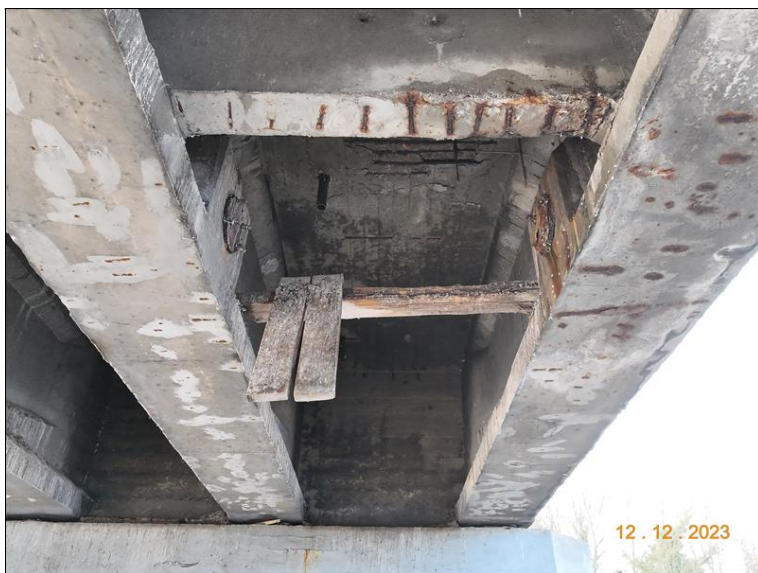
049_Pole č.4 pohled NK mezi N5 a N6. Koroze výztuže, degradace betonu a stopy po zatékání.jpg
