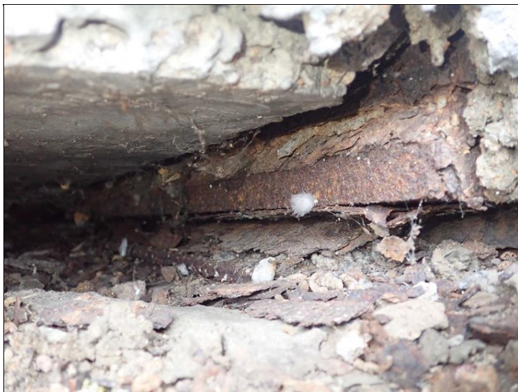
Vrstevnatá koroze ložiska na opěře 1 vlevo.
