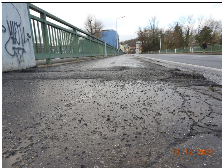
108_MZ P4 - Levý chodník. Výrazné nerovnosti v chodníku - lokálně až 3,0 cm.jpg
