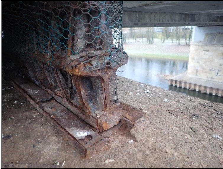
Pohled na ložisko nad Pil 4 vpravo. Typická závada většiny ložisek: vrstevnatá koroze. Na snímku je vidět, že šrouby kotvení ložiska do pilíře buď překorodovaly, nebo nebyly dodány v době stavby.
