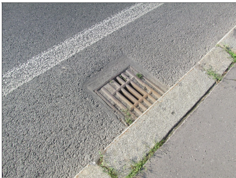
Částečně zanesený odvodňovač.
