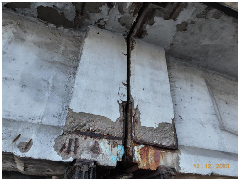
070_P6 dilatace, zprava. Degradace betonu, stopy po zatékání, koroze v místě dilatace.jpg
