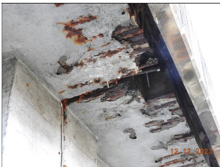
020_P2 dilatace, vpravo. Degradace betonu, koroze výztuže a stopy po zatékání.jpg
