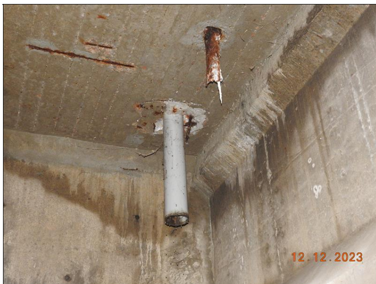
078_Pole č. 6 podhled NK. Stopy po zatékání a koroze výztuže.jpg
