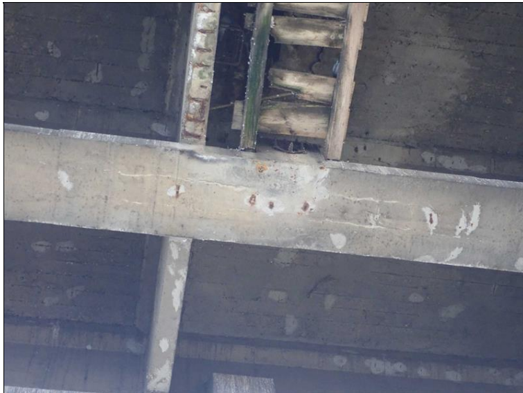
Výluh v trase předpínacího kabelu - pole 5. Rozpad lávky sloužící jako přístup ke stálému zařízení.
