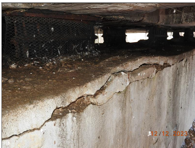
023_P2 úložný práh - detail. Zanesení trusem, podélná trhlina ve spodní části.jpg
