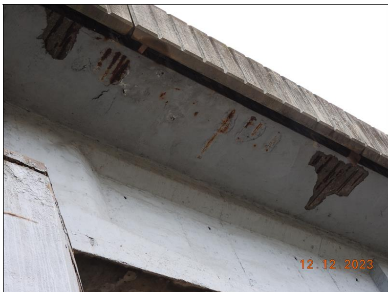
013_Pole č.1 římsa vpravo - detail. Separace krycí vrstvy a koroze výztuže.jpg
