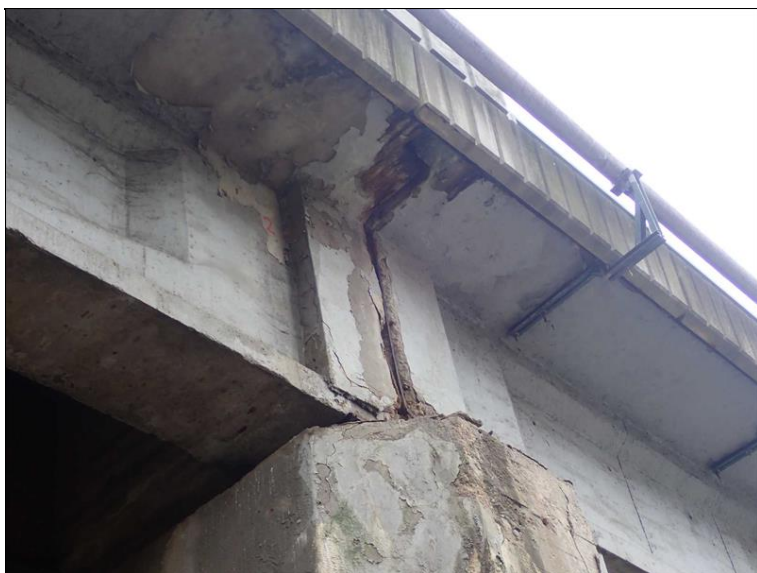
Degradace betonu pilíře 6, značné zatékání z dilatační spáry
