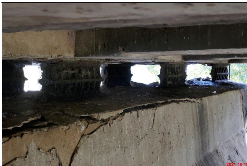
163_koroze lozisek_trhlina na P6.JPG
