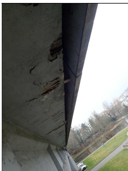
Koroze výztuže konzoly v poli 1.
