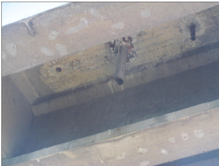
Degradace betonu desky mostovky v místě prostupu odvodňovače.
