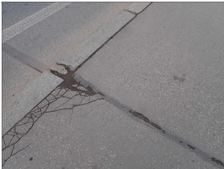
Okolí dilatační spáry v chodníku - síť trhlin, počínající výtluk.
