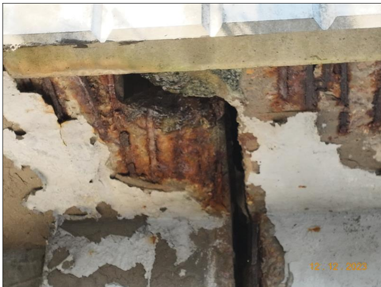
069_P6 římka zleva - detail. Degradace betonu, stopy po zatékání a koroze výztuže.jpg
