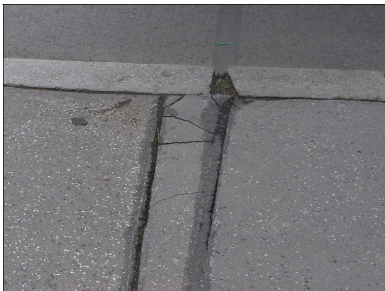
Dilatační spáry na chodníku.
