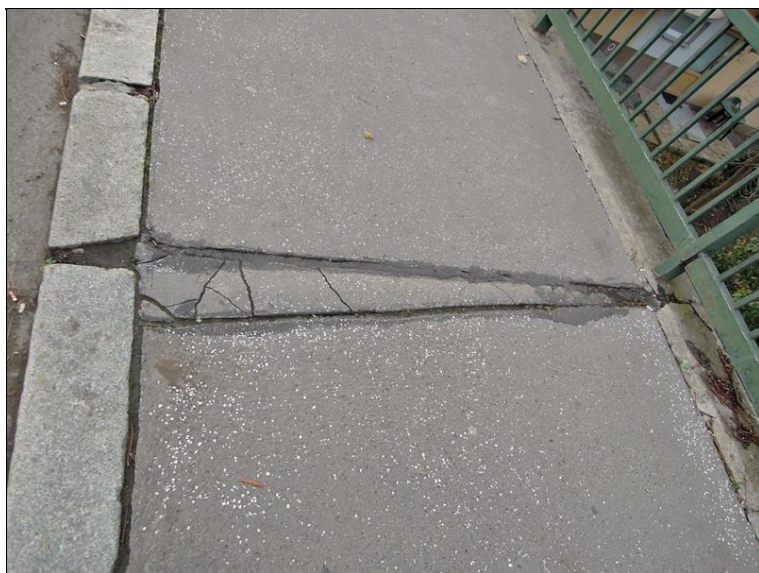
porucha v chodníku v místě dilatační spáry - PS, OP2
