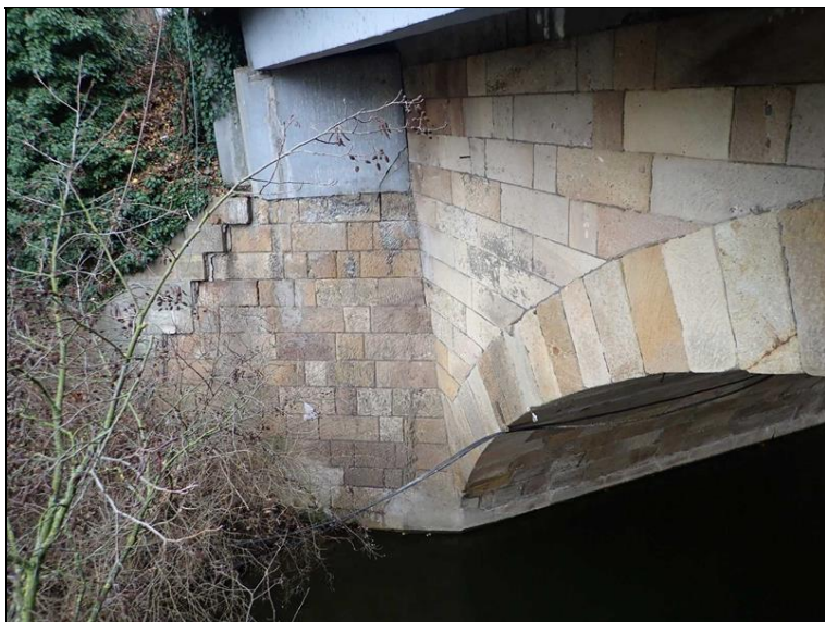
Trhlina v uložení trámu u opěry 1 vpravo.
