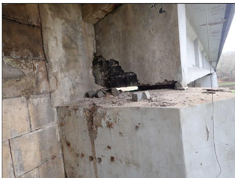
Vlhké zdivo u úložného prahu opěry 1 vpravo.
