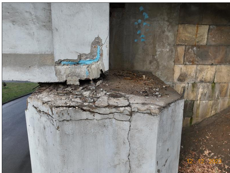
006_Úložný práh OP1, zleva. Rozpad úložného prahu v horní části.jpg
