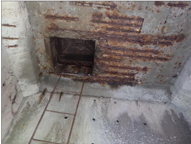
Pole 4: zatékání kolem otvoru, koroze výztuže s oslabením.
