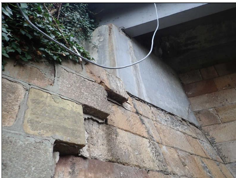
Vysunuté bloky křídla u opěry 1 vpravo.
