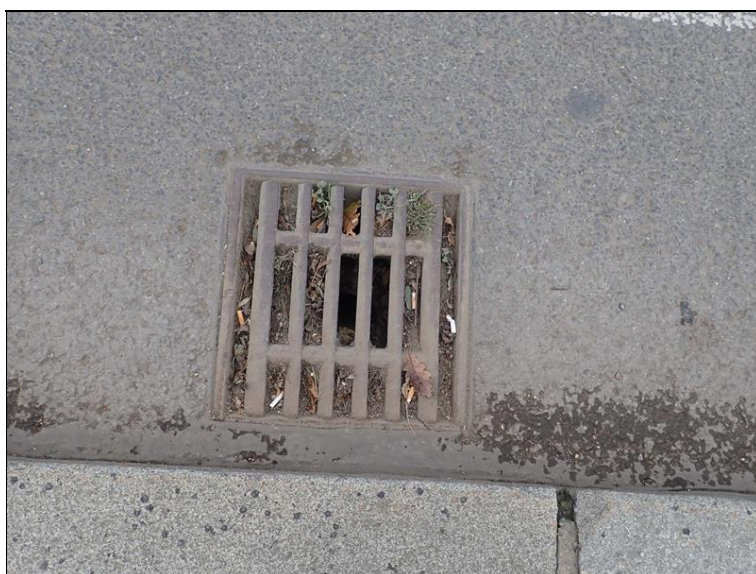
Nánosy v odvodňovači.
