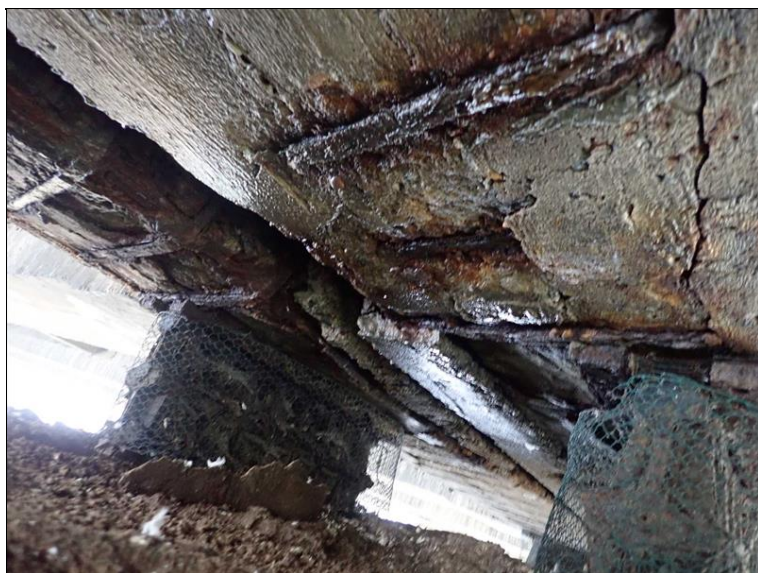
Pohled na dilatační spáru Pil 5: Odpadlé kusy betonu, koroze výztuže, zatékání.
