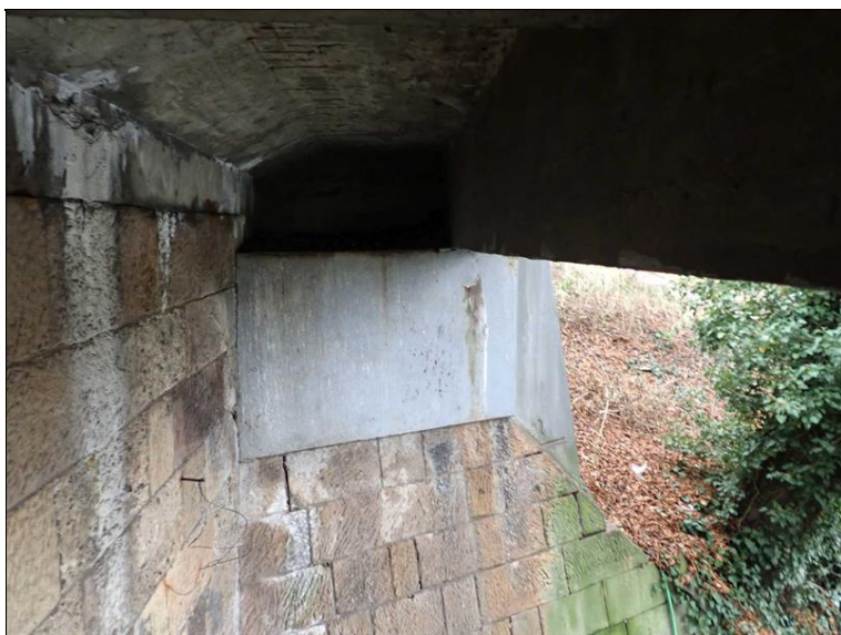
Silný výluh z betonové části čelní zdi, šikmá trhlina v křídle opěry 2 vpravo.
