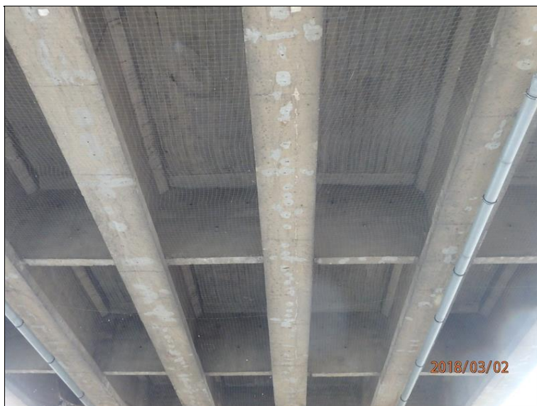
Trhliny s výluhy poжива kopírující trajektorii předpínacích kabelů.
