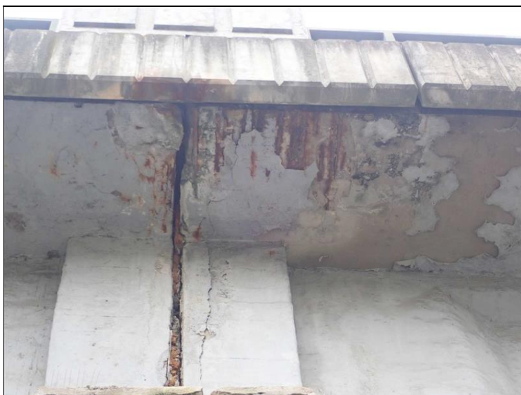
Koroze výztuže u dilatace nad pilířem 2.
