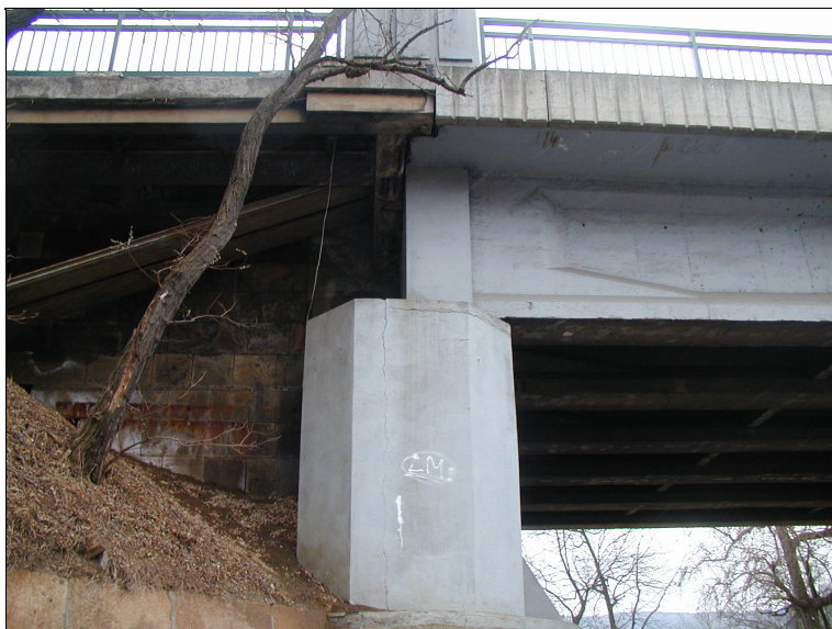
Pohled na pravou stranu opěry 1. Trhliny v místě pracovních spár.
