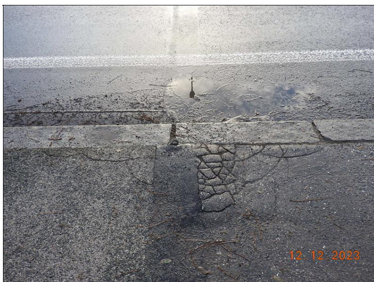
103_MZ OP1 - detail. Dochází k zvlnění v místě pravého chodníku.jpg
