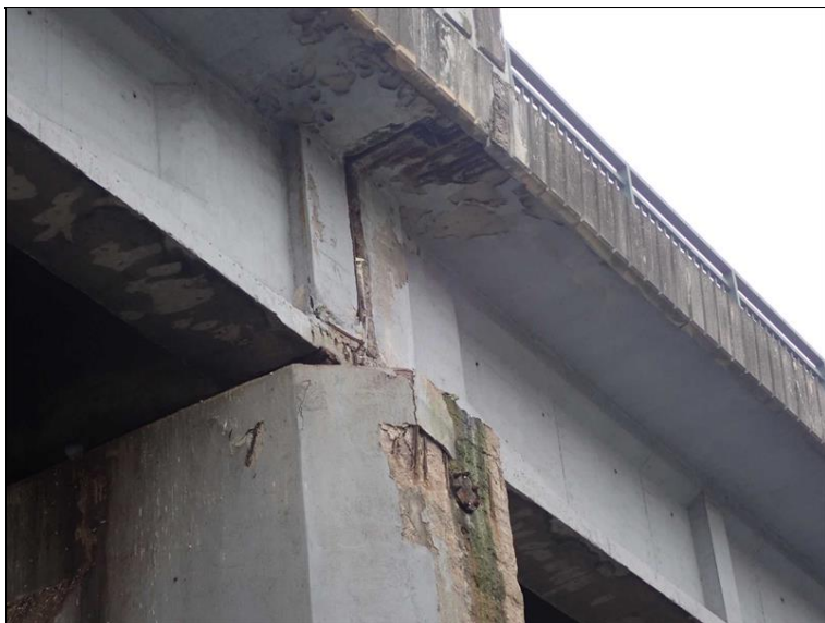
Pilíř 4 - značné zatékání dilatační spárou, odpadávající krytí a koroze výztuže, zatékání i na pilíř, degradace betonu.
