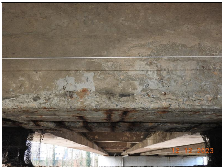
022_NK nad P2. Podélná trhlina ve spodní části, korozí výztuže a separace krycí vrstvy.jpg
