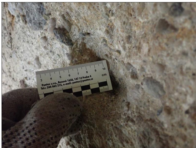
Hlubková degradace bloků - běžně kolem 1 cm, lokálně až 3 cm.
