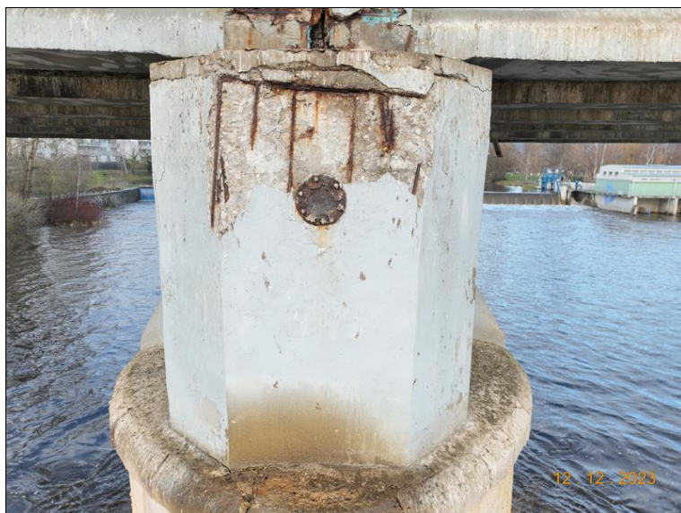
054_P5 zleva. Degradace betonu a koroze výztuže.jpg
