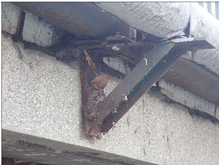
Upevnění inženýrských sítí vrstevnatě koroduje.
