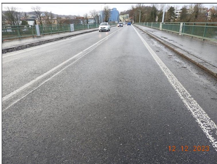
089_Vozovka. Zvlněná v místech MZ, zanesené krajnice.jpg
