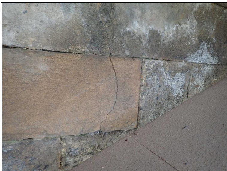
Trhlina v křídle opěry 1 vpravo.
