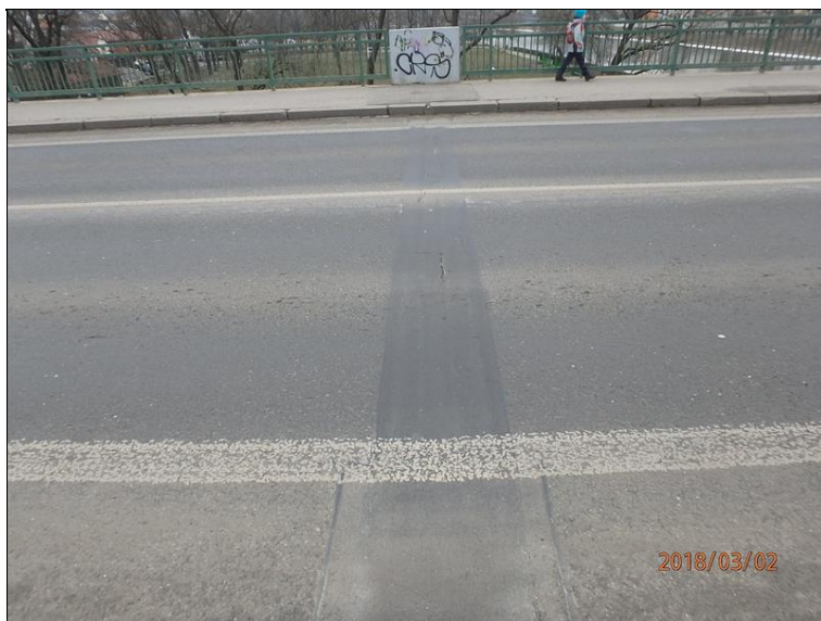
Mostní závěr s příčnými trhlinami.
