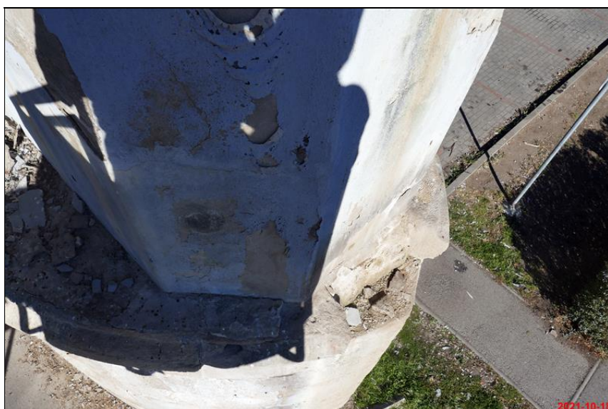
129_1_degradace povrchu pilire.JPG
