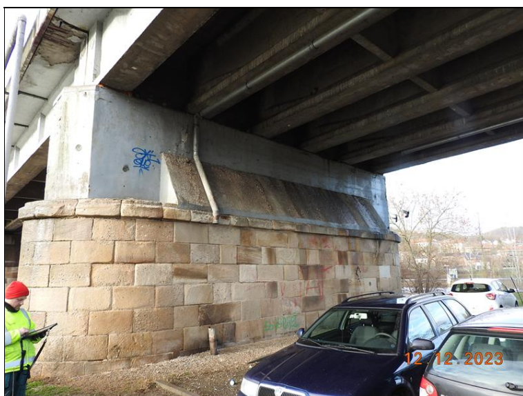
029_P3 po směru staničení. Degradace krycí vrstvy, koroze výztuže, vodorovná trhlina v horní části úložného prahu a zanesení trusem.jpg
