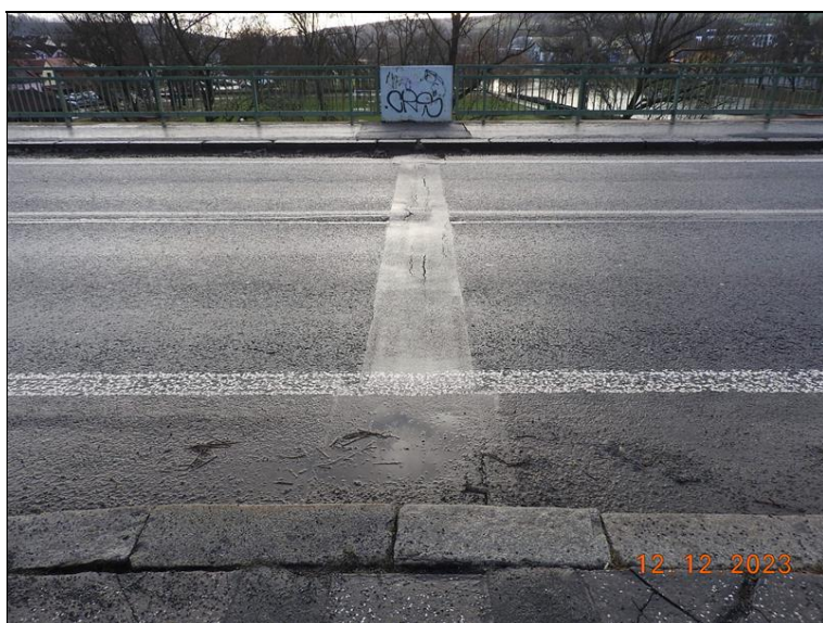
104_MZ P2. Příčné trhliny.jpg
