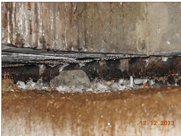
034_P3 ložisko č. 4, Rozsáhlá koroze.jpg
