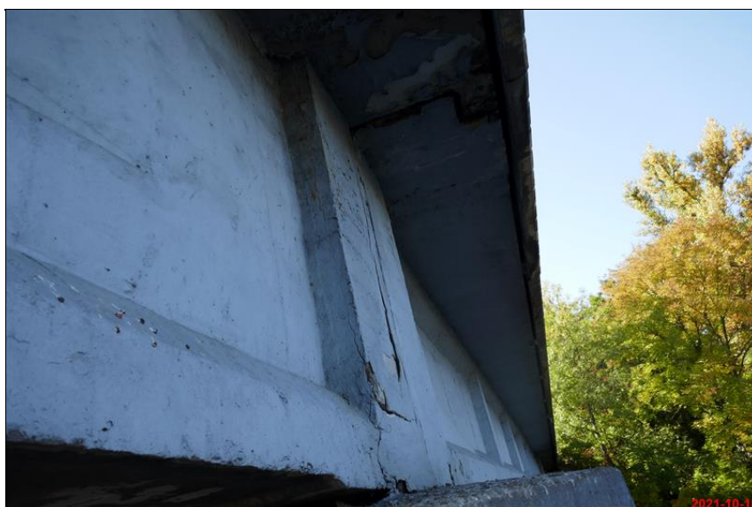
236_trhliny NK nad pilířem P3.JPG
