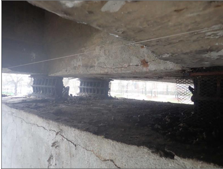
Odtrhlo se cca 5 cm v horní části úložného prahu. Foto Pil 2, situace stejná na všech opěrách i pilířích.
