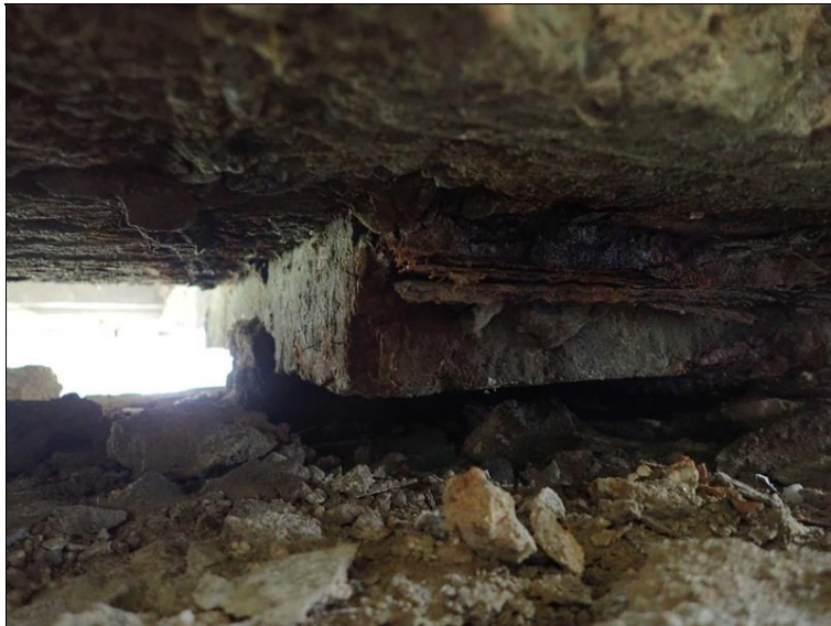
Ložisko na opěře 1 vpravo - vrstevnatá koroze.
