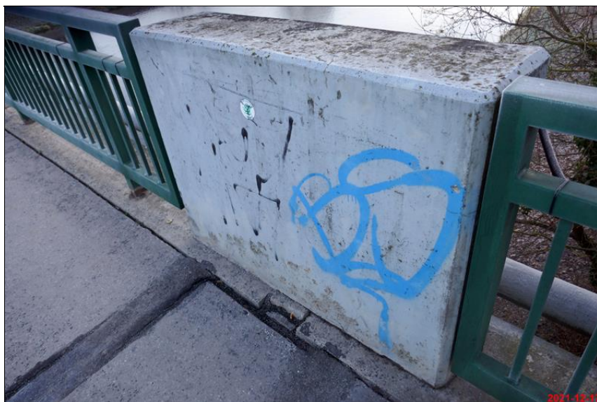
423_nezatesnene trhliny v miste dilatace.JPG
