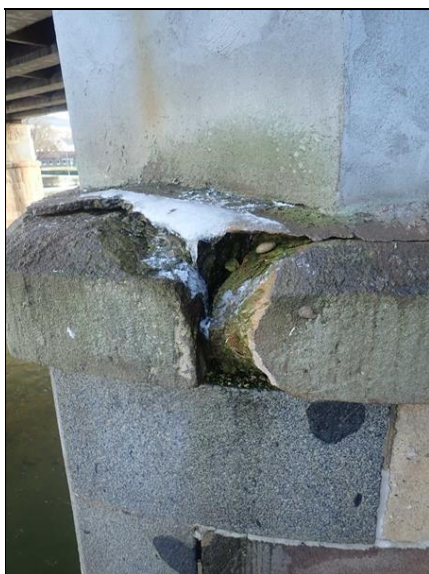
Rozpad kamenného límce Pil 4.
