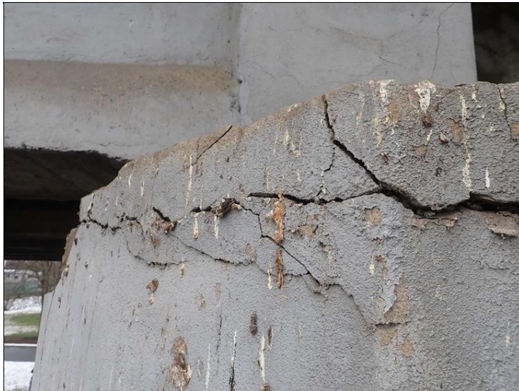
Odtrhlo se cca 5 cm v horní části úložného prahu. Foto Op 1.
