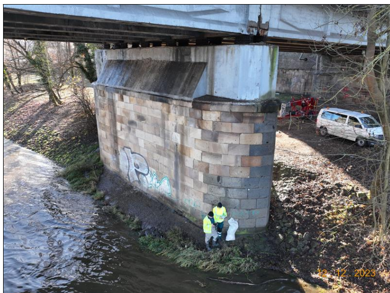
064_P6 po směru staničení. Stopy po zatékání, degradace betonu v horní části.jpg
