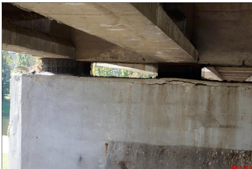
129_2_trhlina v pilíři.JPG
