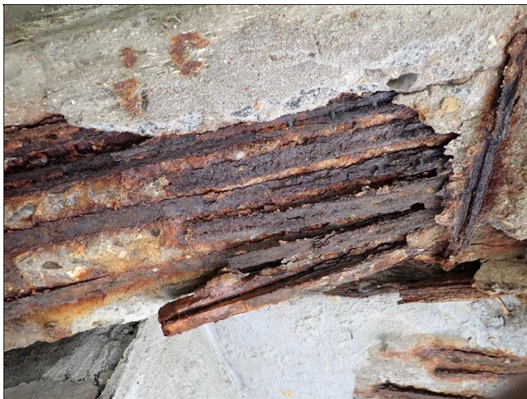
Vrstevnatá koroze výztuže konzoly.
