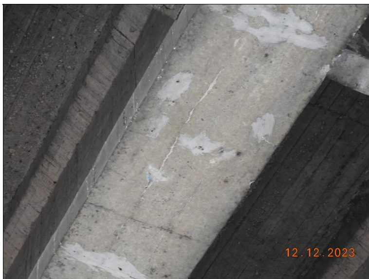
027_Pole č. 2, N4 - detail. Podélná trhlina s výluhem v celé délce spodní pásnice.jpg
