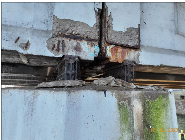
071_P6 ložiska, zprava. Rozsáhlá koroze, stopy po zatékání.jpg
