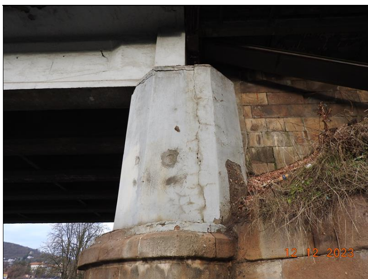
005_OP1, vlevo - detail. Svislá trhлина v celé výšce bet. konstrukce.jpg
