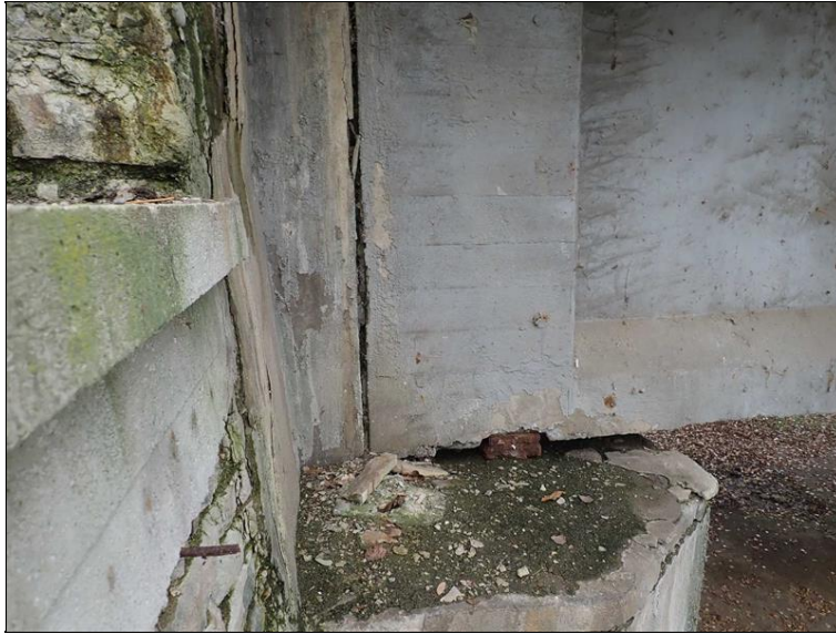
Levé křídlo opěry 7 - degradace betonu, nánosy na úložném prahu.
