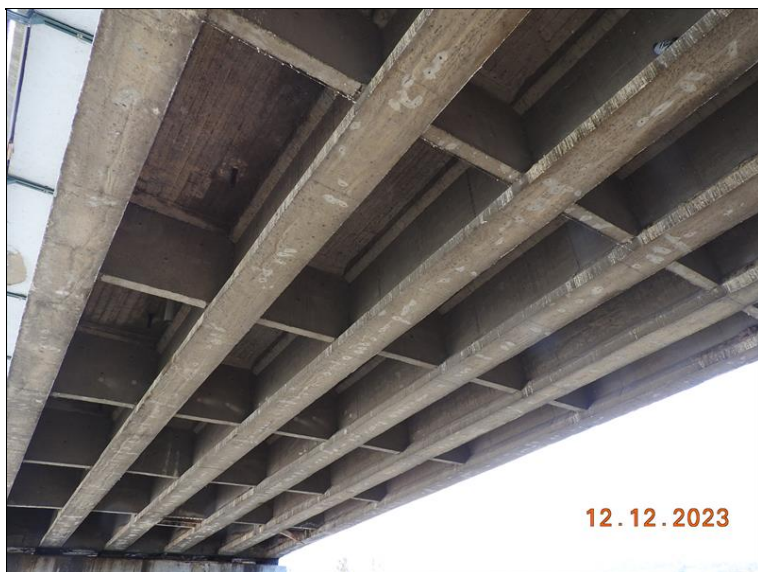
036_Pole č. 3 podhled nosné konstrukce. Degradace betonu, stopy po zatékání a koroze výztuže.jpg
