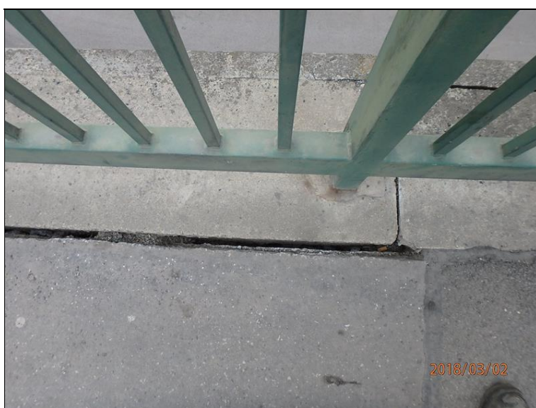
Chybějící zálivka mezi chodníkem a římsou
