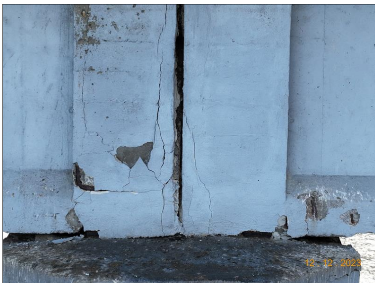
058_P5 dilatace, zprava. Porušená krycí vrstva.jpg
