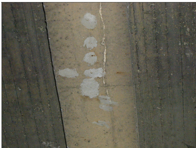
Podélná trhlina na sp. líci nosníku s výluhy pojiva.
