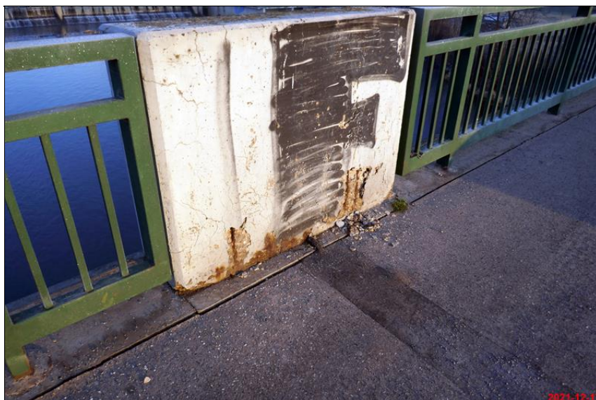
444_odstrelující krycí vrstva.JPG
