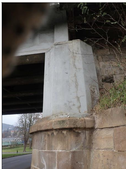
Svislá trhlina v opěře 1 vlevo.
