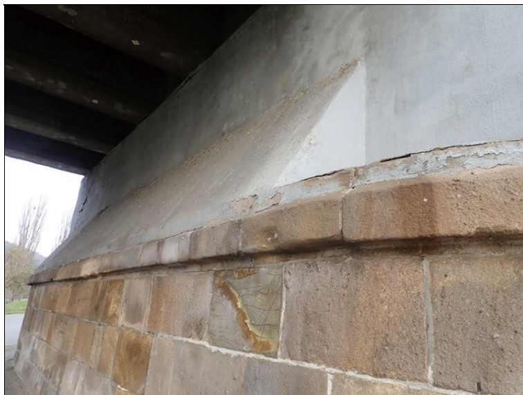
Líc opěry 1 - separace krycí vrstvy v hraně úložného prahu, povrchová degradace obkladního zdiva.
