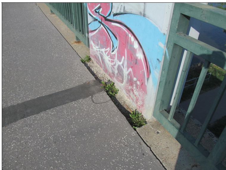
Nedokončený povrch u sloupku na pravém kraji chodníku.
