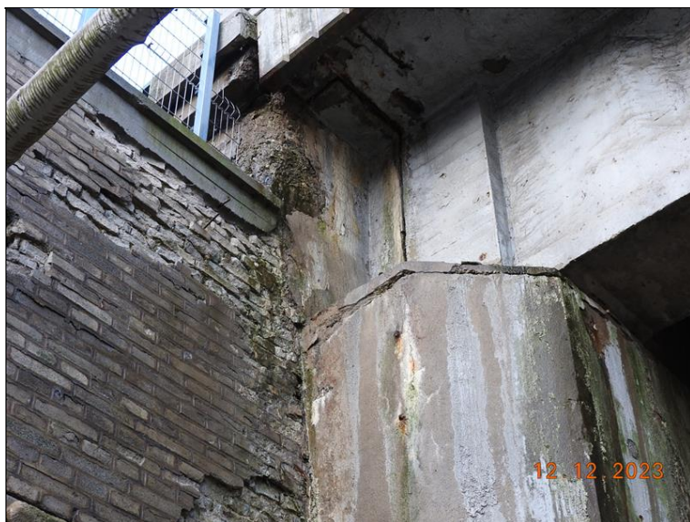
082_Levé křídlo OP7. Výluhy s oxidy železa.jpg
