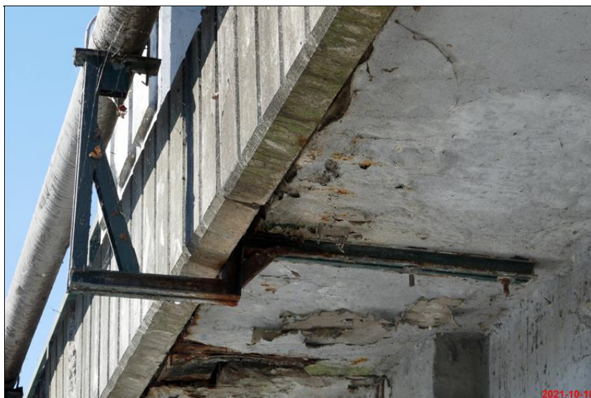
402_koroze nosice cizího zařízení.JPG
