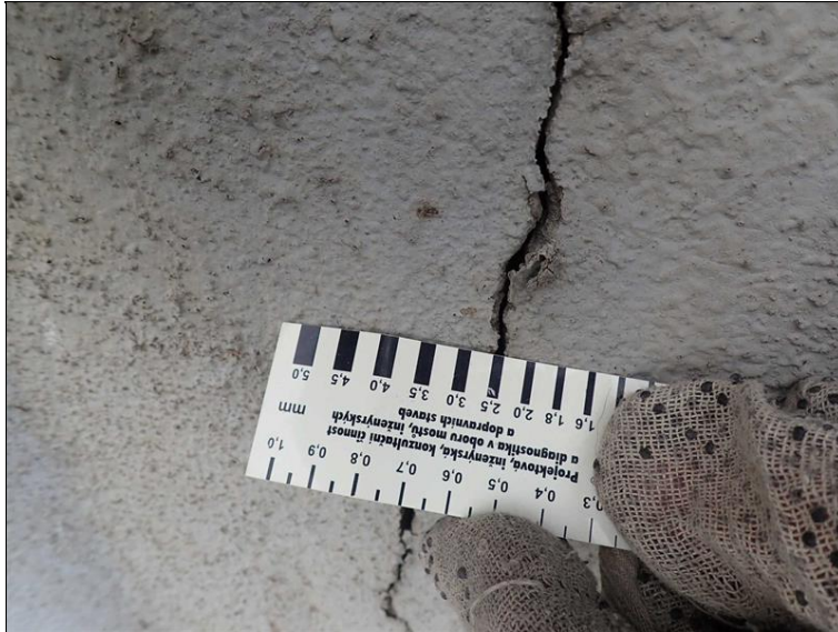
Šířka svislé trhliny v úložném prahu opěry 1 vlevo.
