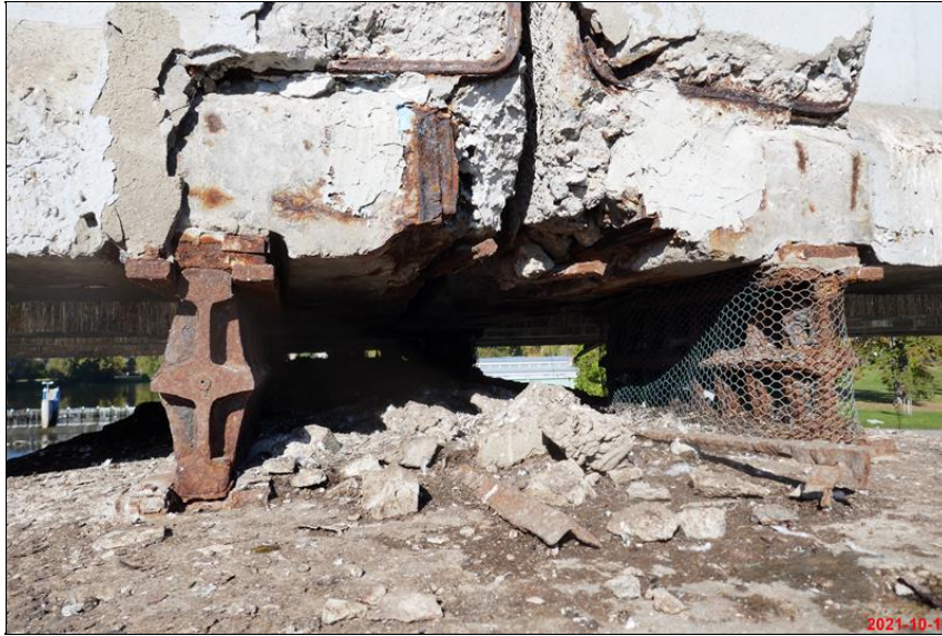
239_7_koroze ložisek_kotveni_odpad betonu.JPG
