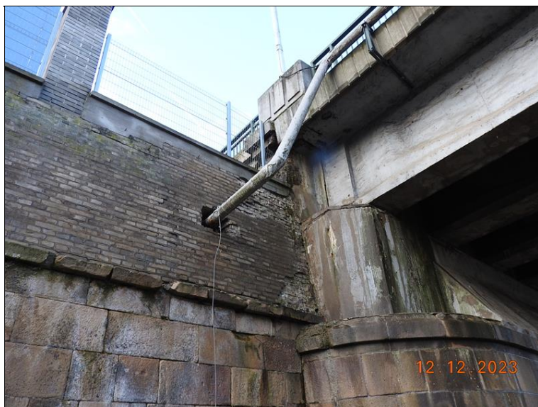
081_Levé křídlo OP7. Stopy po zatékání, degradace zdiva.jpg
