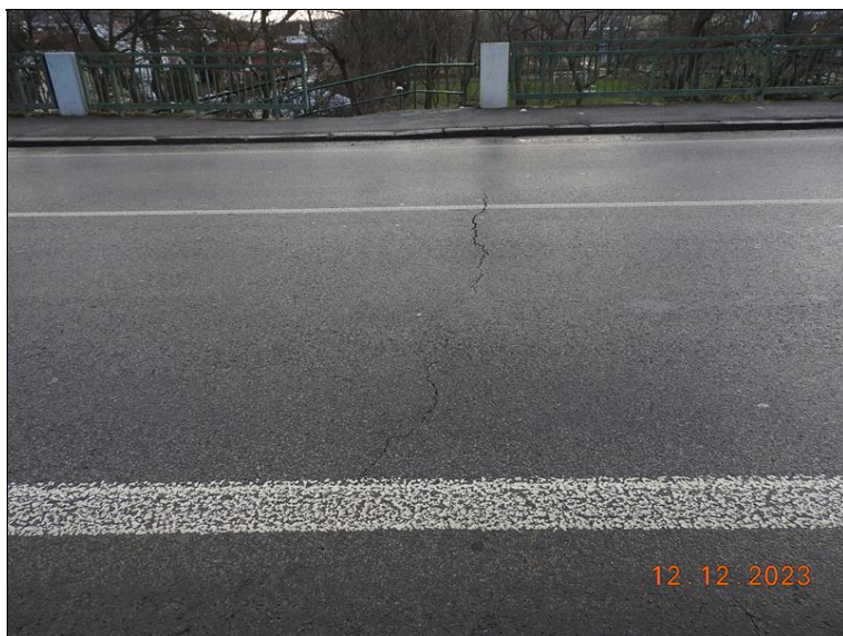
117_Přechodová oblast u OP1 - detail. Příčná trhlina.jpg
