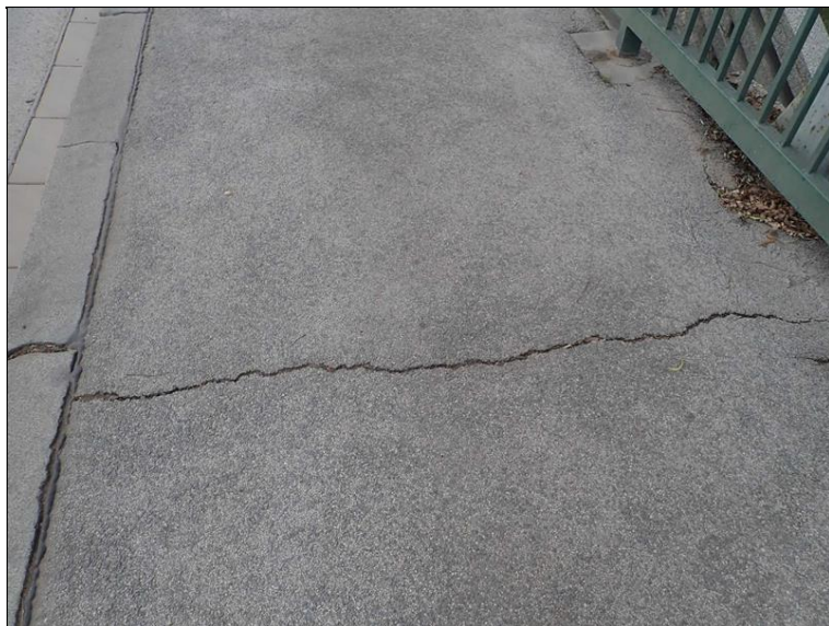
Trhlina v chodníku nad opěrou 1.
