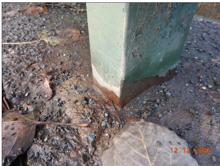
093_Zábradlí, vpravo - detail - typická porucha. Koroze v místě kotvení.jpg
