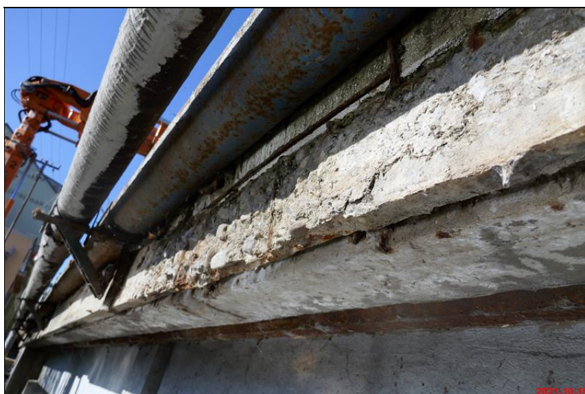
39_degradovany beton rims.JPG
