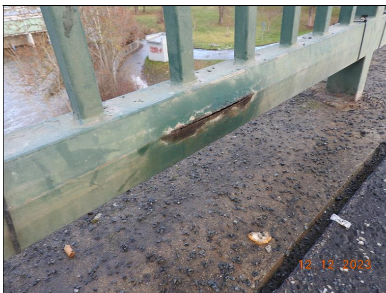
092_Zábradlí, vpravo. Deformace profilu.jpg
