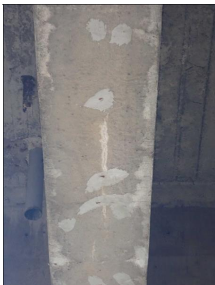
Výluh v trase předpínacího kabelu - pole 6.
