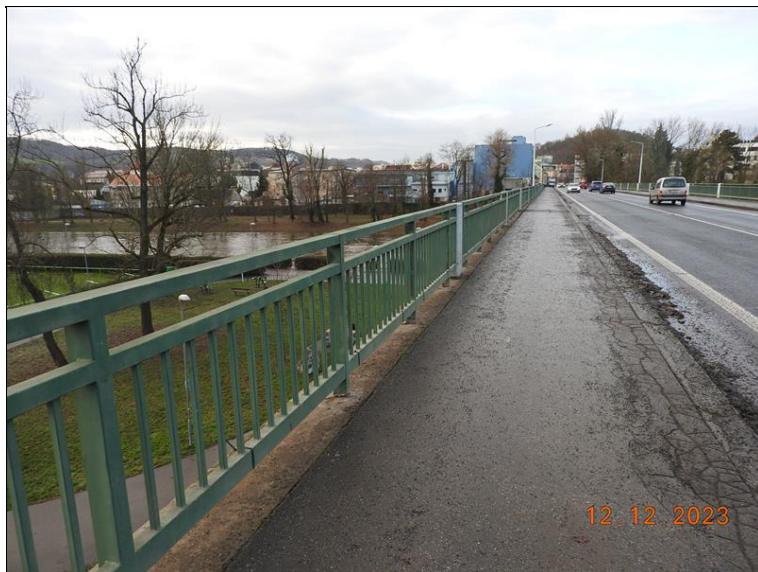
090_Zábradlí a chodník, vlevo. Povrchová degradace, neodtékající voda, chybějící těsnící zálivka viz pravá strana.jpg
