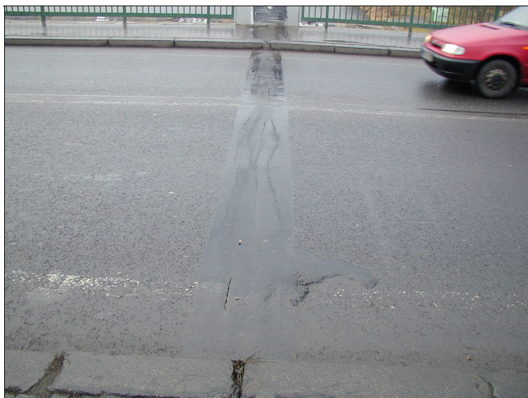
Deformace a trhliny v dilatačním závěru ve vozovce.
