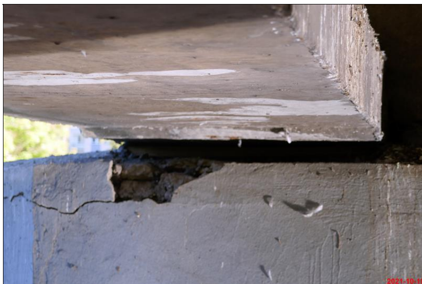
141_odlupující se beton na pilíři P4.JPG
