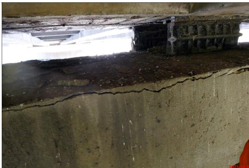
161_trhlina v betonu na P6.JPG
