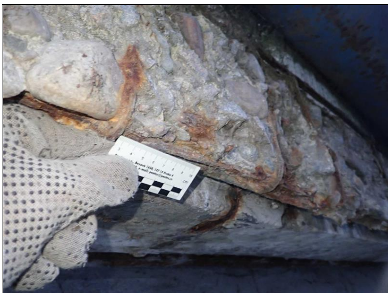
Beton levé římsy - rozpadá se, koroduje výztuž.
