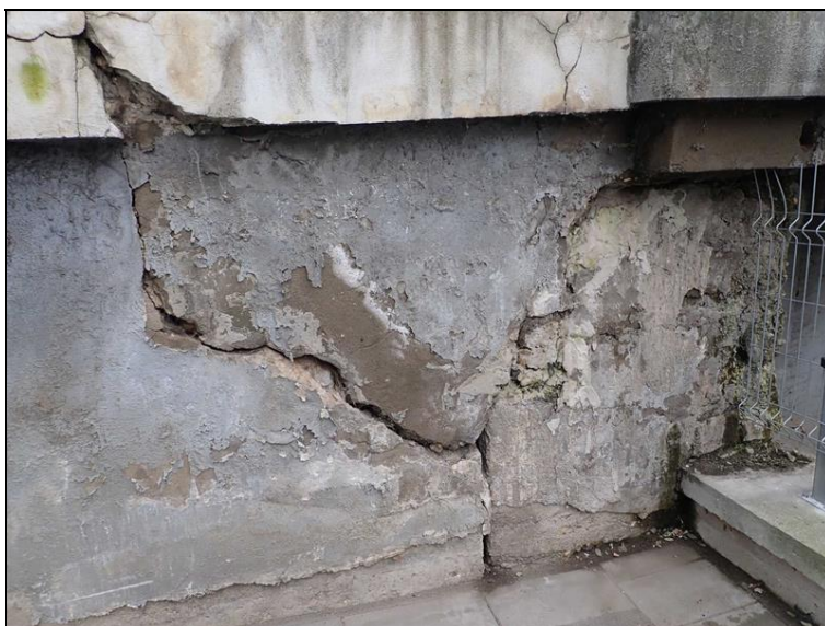
Levé křídlo opěry 7 - šikmé široké trhliny s degradací betonu.
