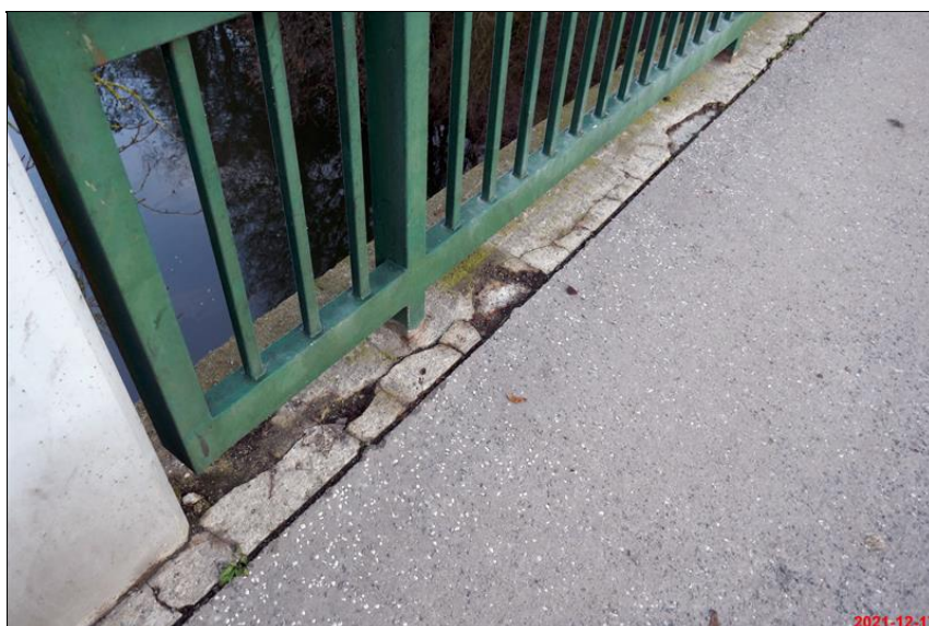
17_degradovany beton rimsy.JPG
