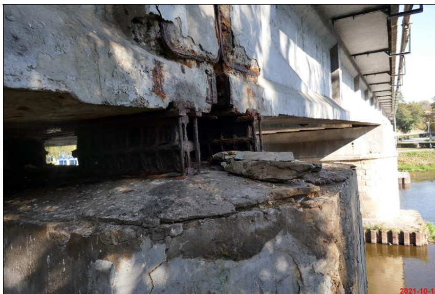
267_degradace betonu NK nad pilířem P6.JPG
