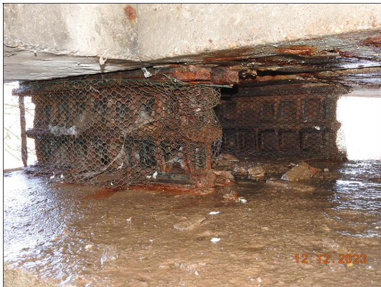
075_P6 ložisko 6. Rozsáhlá koroze.jpg
