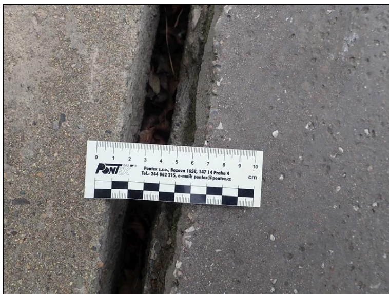
Mezi dobetonávkou římsy a chodníkem jsou nezatěsněné spáry.
