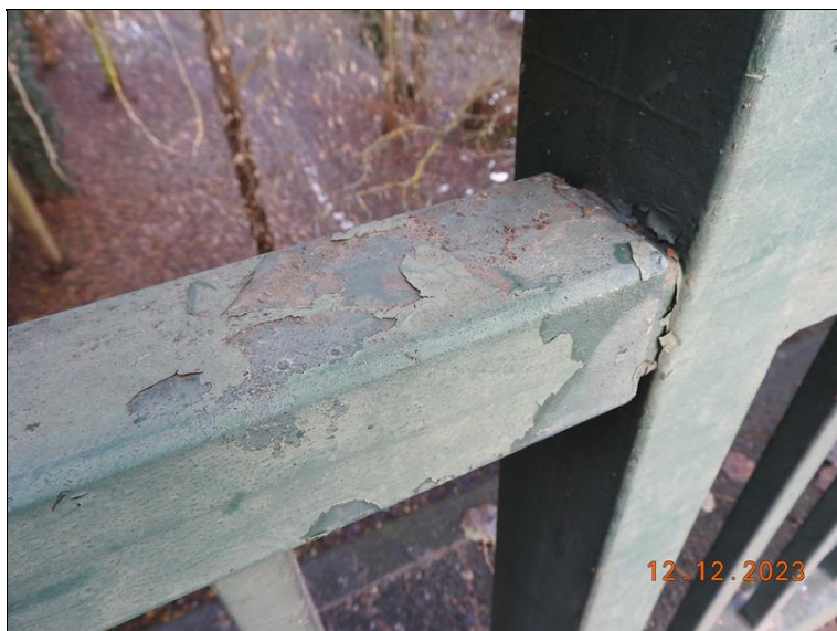
094_Zábradlí, vpravo - detail - typická porucha. Degradace PKO.jpg
