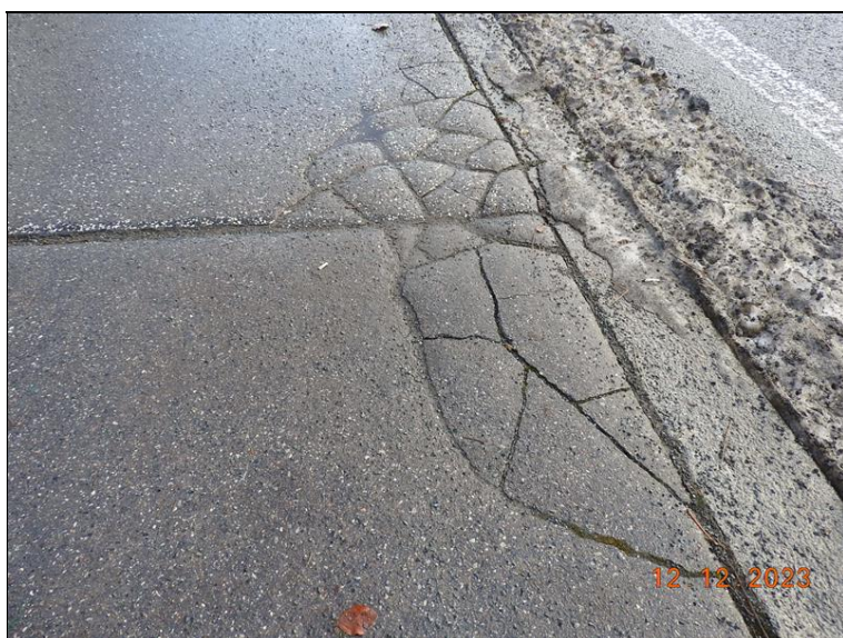
098_Pravý chodník. Lokálně trhliny, neodtékající voda, degradace těsnících zálivek.jpg
