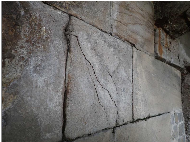
Blok zdiva opěry1 vlevo - trhliny.
