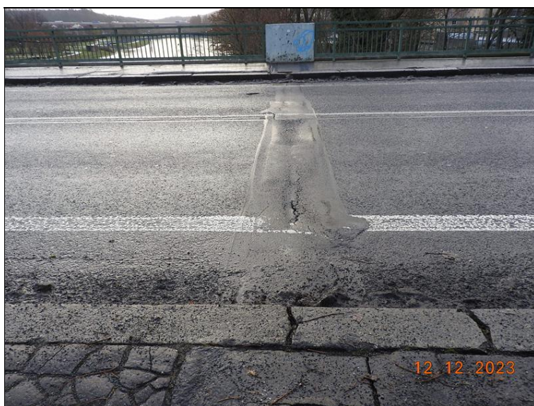
110_MZ P6. Příčná trhlina v celé šíři, všesměrné trhliny.jpg
