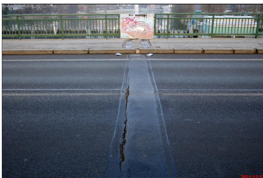
433_celkovy pohled na MZ s trhlinou.JPG
