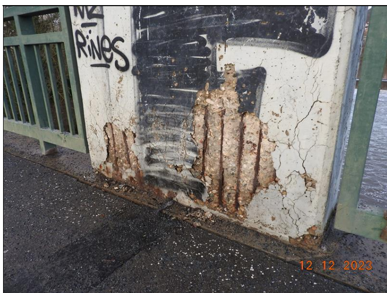
095_Zábradlí, vpravo - detail. Degradace krycí vrstvy a rozsáhlá koroze výztuže.jpg
