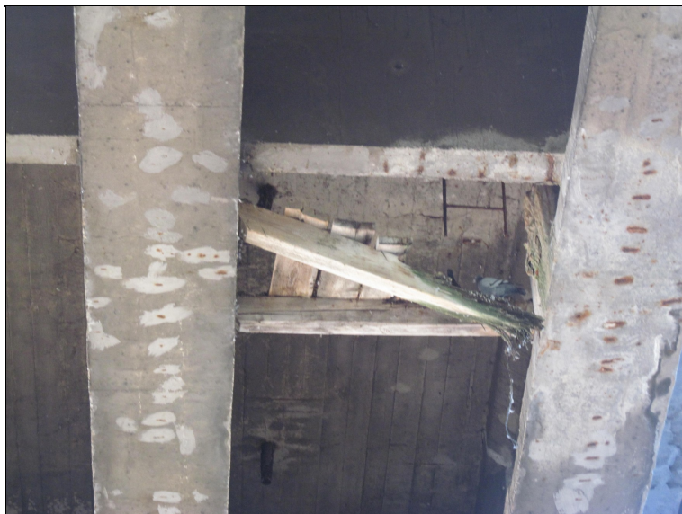
Dřevěné podlážky u stálého zařízení se rozpadají.
