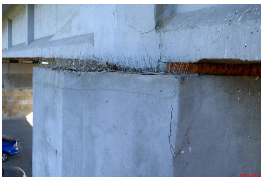
123_trhlinka v pilíři.JPG
