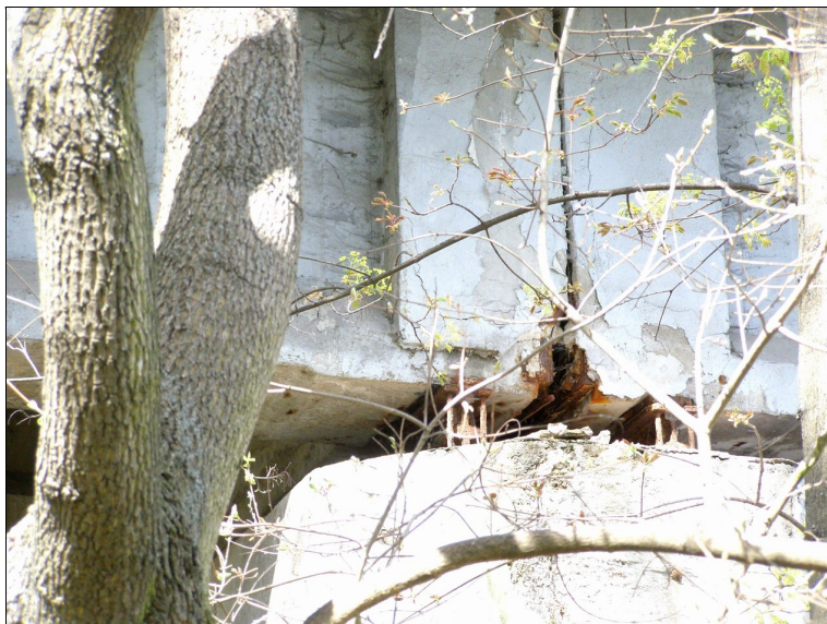
Spodní líc trámu NK - podélné trhliny s výluhy pojiva
