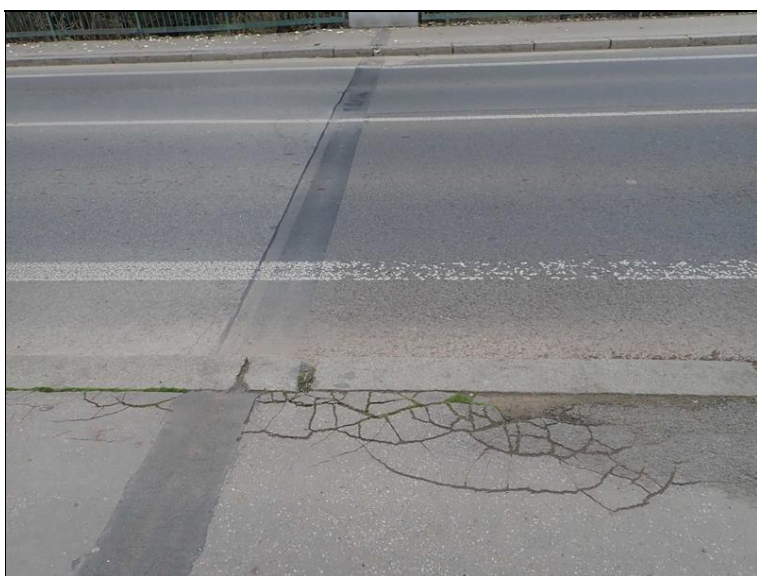
Dilatační závěr nad piliřem 6. Je odtržený, v okolí trhliny, zejména v chodníku.
