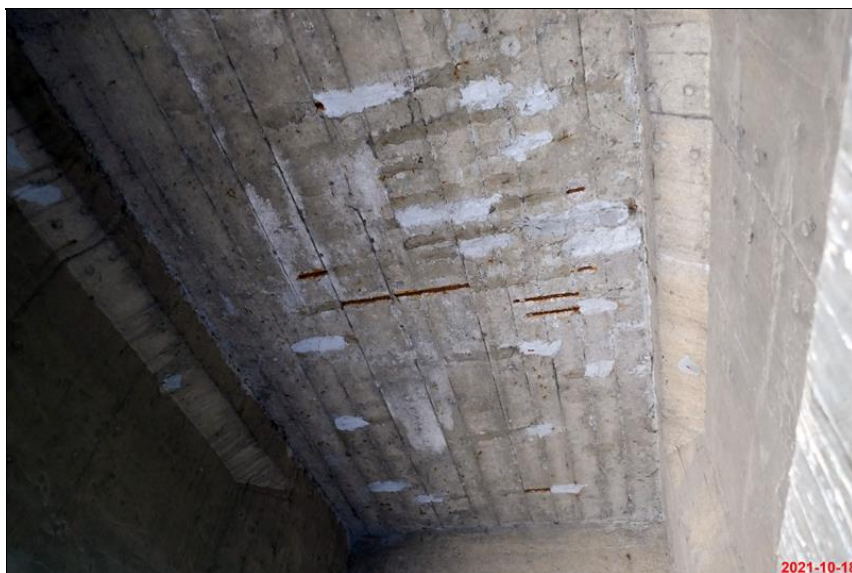
212_koroze vyztuze na podhledu NK.JPG
