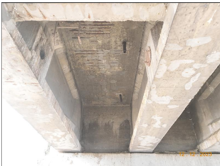
050_Pole č.4 pohled NK mezi N1 a N2. Degradace betonu a koroze výztuže.jpg
