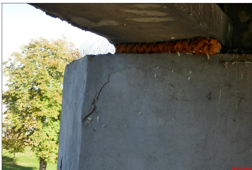
122_odstrelující krycí vrstva.JPG
