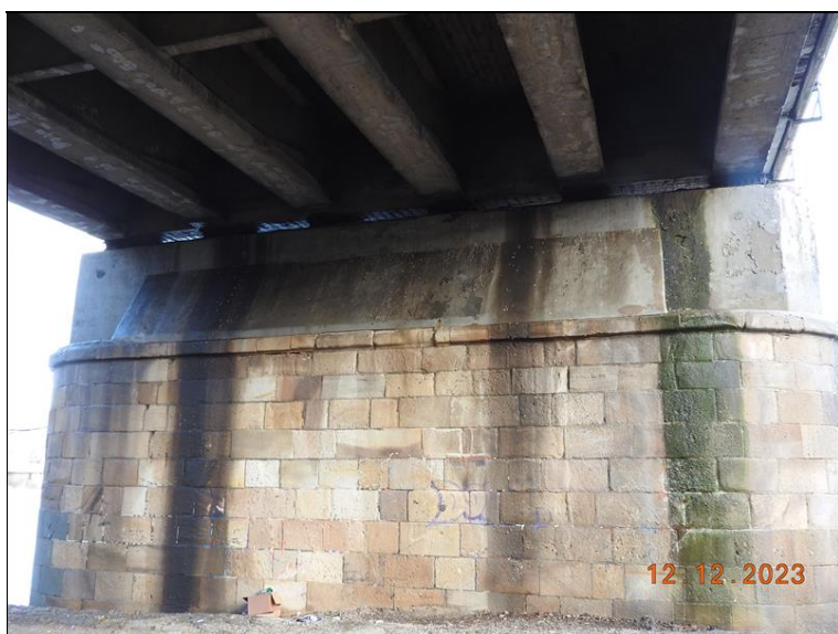
065_P6 proti směru. Stopy po zatékání a degradace betonu.jpg
