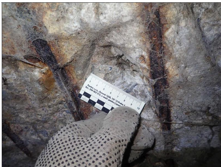
Odpadlý beton v okolí korodující výztuže.
