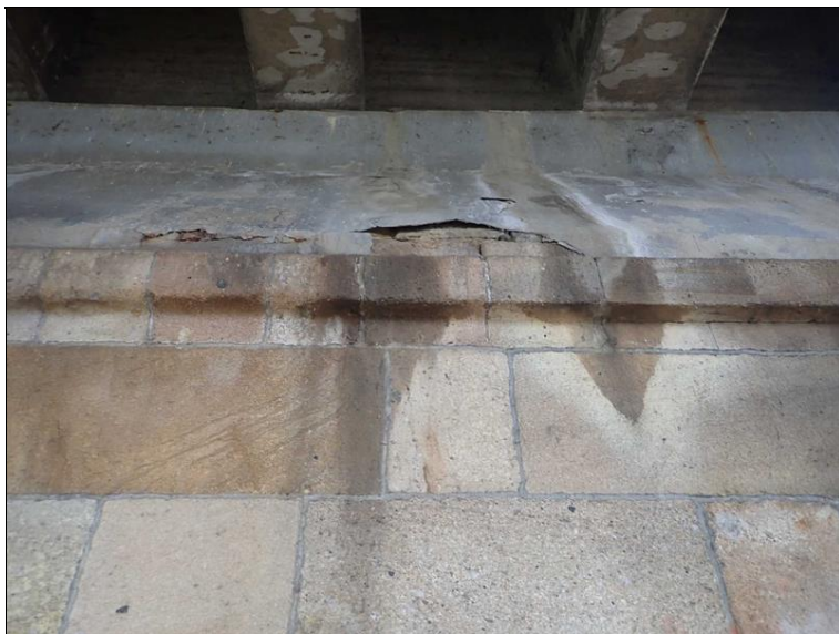
Odpadávající krycí vrstva z líce opěry 7.
