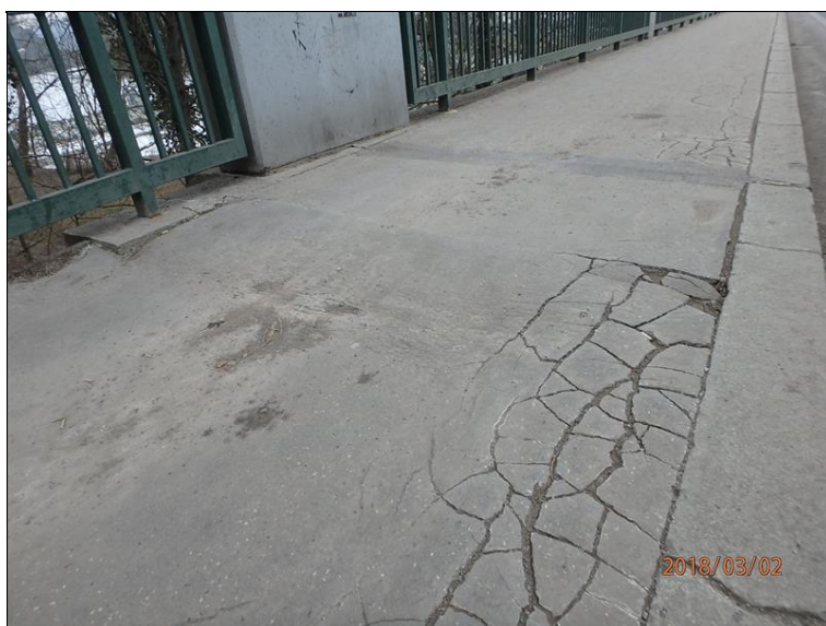
Trhliny v krytu chodníku.
